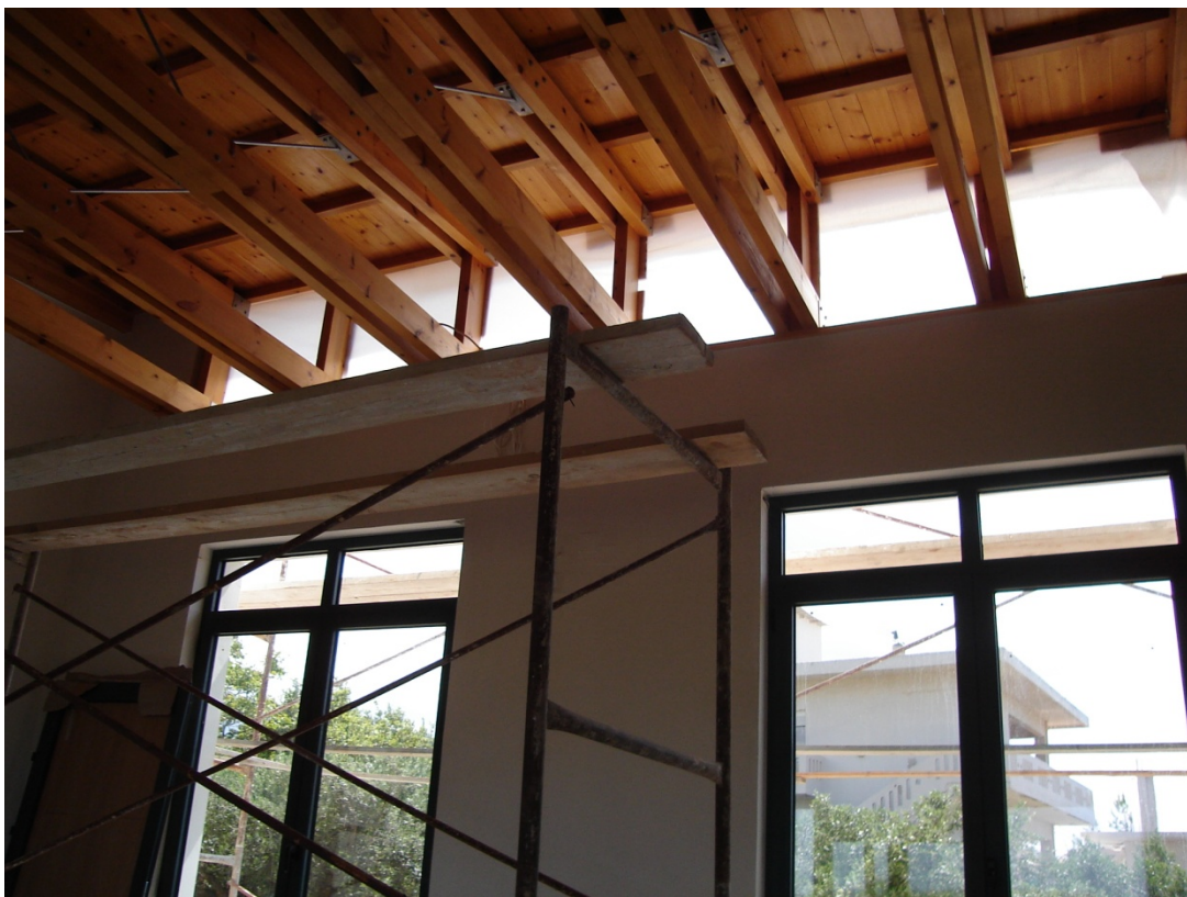
Σύστημα ηλιοπροστασίας- Ανοίγματα στη νοτιοδυτική πλευρά του κτιρίου
