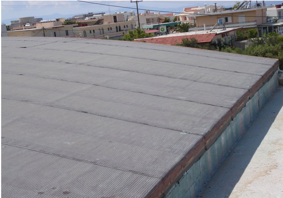
Μόνωση στη στέγη
