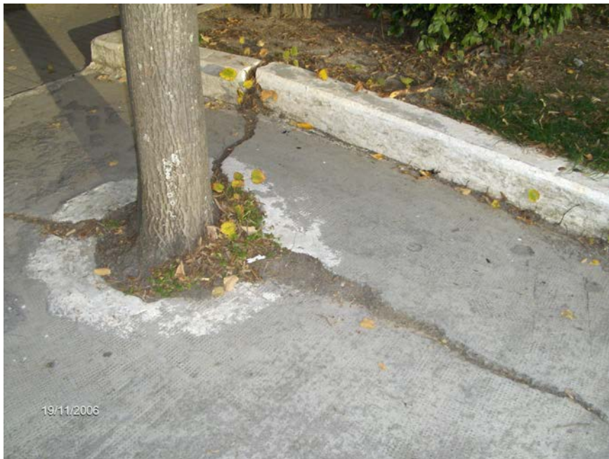
Χαρακτηριστικό παράδειγμα των ρωγμών του τσιμέντου της πλατείας .
