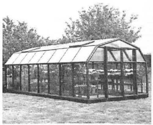
Εικόνα 2: Μεταλλικός σκελετός με γυάλινα φύλλα
