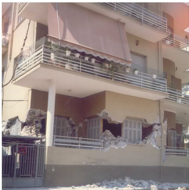
Εικόνα 22. Σημειακή αποκόλληση τοιχοποιίας από διατμητικές δυνάμεις κατά τη διάρκεια σεισμού στη Καλαμάτα
