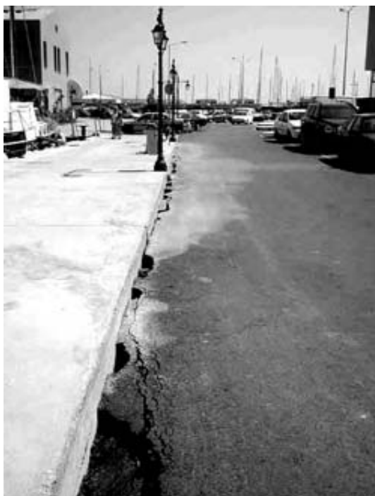
Εικόνα 47. Μαρίνα Λευκάδας. Ανάδυση λεπτόκοκκου υλικού.
