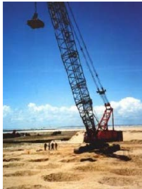
Εικόνα 17. Αποτύπωση εργασιών προφόρτισης του εδάφους σε τεχνικό έργο στην Αμερική
