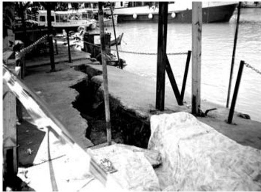
Εικόνα 44. Βύθιση και στροφή του κρηπιδώματος.
