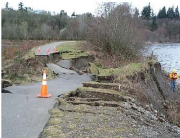
Εικόνα 49. Hokkaido Japan 2003, καθίζηση οδοστρώματος
