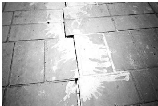
Εικόνα 45. Ανάδυση λεπτόκοκκου υλικού.
