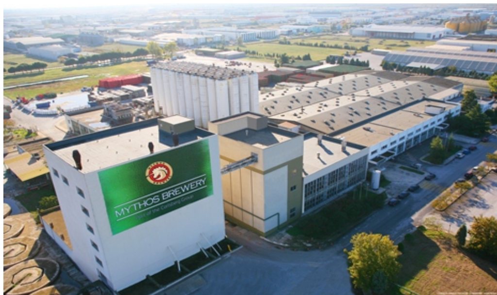
ΕΙΚΟΝΑ 1 : ΕΡΓΟΣΤΑΣΙΟ ΠΑΡΑΓΩΓΗΣ ΤΗΣ ΜΥΘΟΣ ΖΥΘΟΠΟΙΑΣ ΑΕ.
