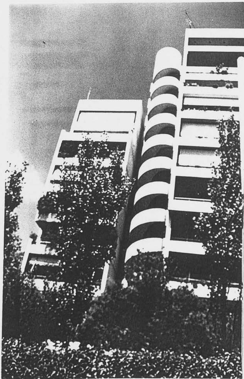
Σκάλα από οπλισμένο σκυρόδεμα σε κτίριο επί της λεωφόρου Μεσογείων
