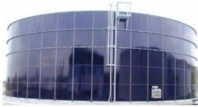
Σχήμα 4.2: Βιοαντιδραστήρας – Χωνευτήρας – Δεξαμενή Αναερόβιας Χώνευσης [25]
