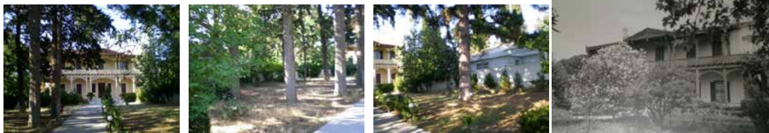
Εικόνα 174: Κατοικία στην οδό Δηλιγιάννη 11
