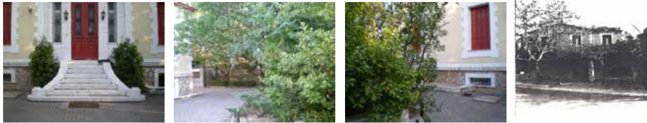
Εικόνα 170: Κατοικία στην οδό Δηλιγιάννη 30
