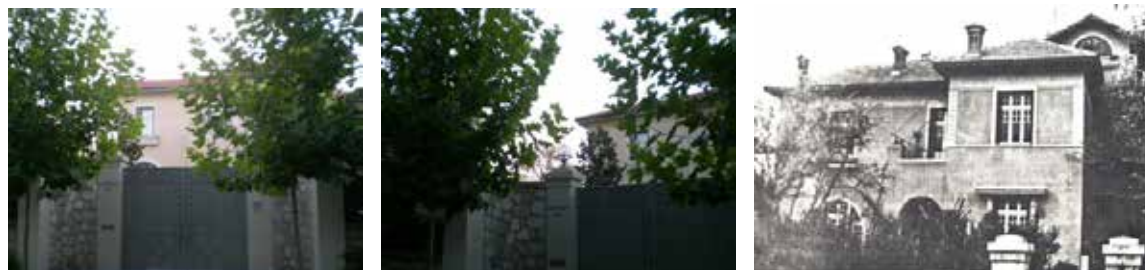
Εικόνα 185: Κατοικία στην οδό Διονύσου 13
