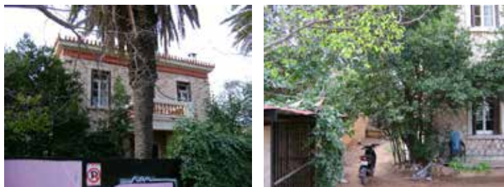
Εικόνα 164: Κατοικία στην οδό Τατοΐου 11
