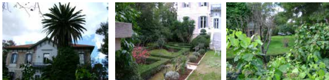
Εικόνα 158: Κατοικία στην οδό Τατοΐου 33
