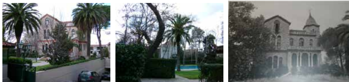
Εικόνα 159: Κατοικία στην οδό Τατοΐου 31
