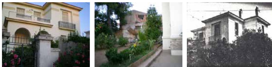
Εικόνα 187: Κατοικία στην οδό Διονύσου 30
