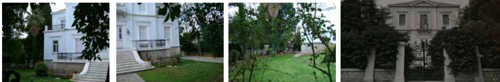
Εικόνα 160: Κατοικία στην οδό Τατοΐου 29
