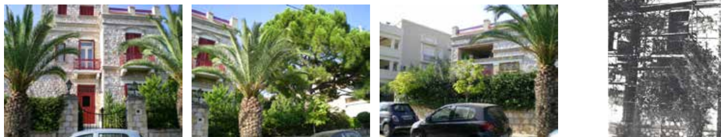
Εικόνα 129: Κατοικία στην οδό Πεσμαζόγλου 36 & Αθ. Διάκου
