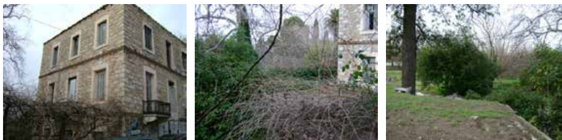
Εικόνα 166: Κατοικία στην οδό Τατοΐου 1
