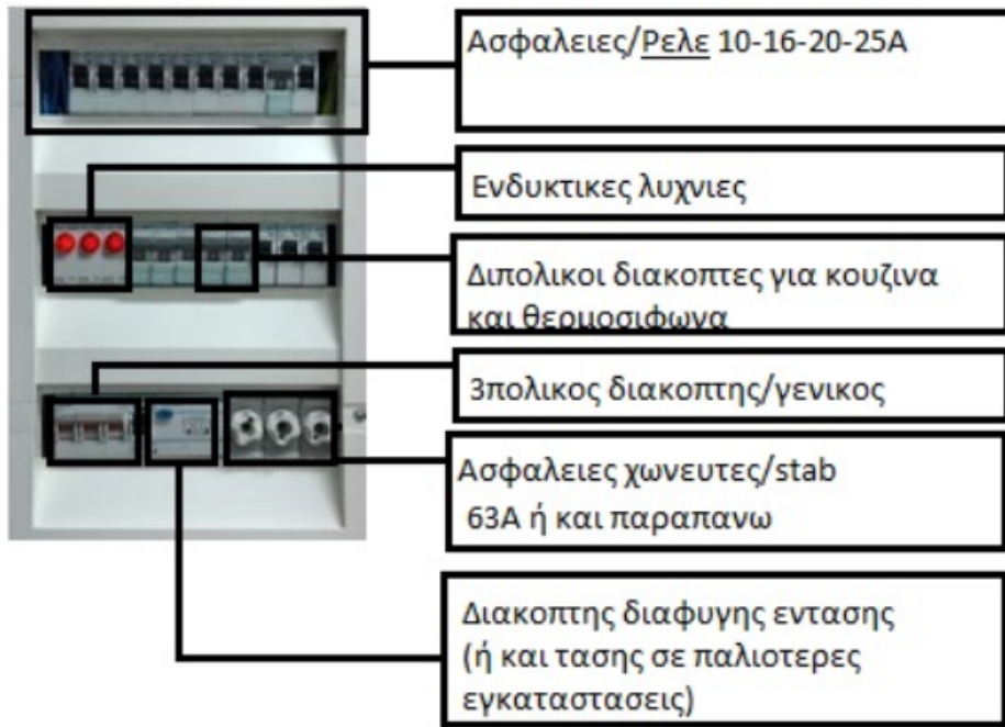
Εικόνα 2.8.2.1: Ηλεκτρικός πίνακας
