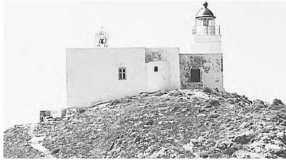
Εικόνα 11. Στην είσοδο του λιμανιού της Κέας, δίπλα στο εκκλησάκι του Αγίου Νικολάου, κτίστηκε το 1831 ένας από τους πρώτους ελληνικούς φάρους. Ο φάρος υπέστη δύο αλλαγές, το 1860 και το 1893, και το παλαιό εκκλησάκι επεκτάθηκε.
