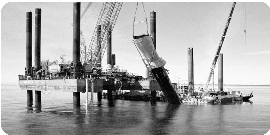
Εικόνα 3.9.3: Εγκατάσταση Α/Γ στο αιολικό πάρκο Yttre Stengrund.
