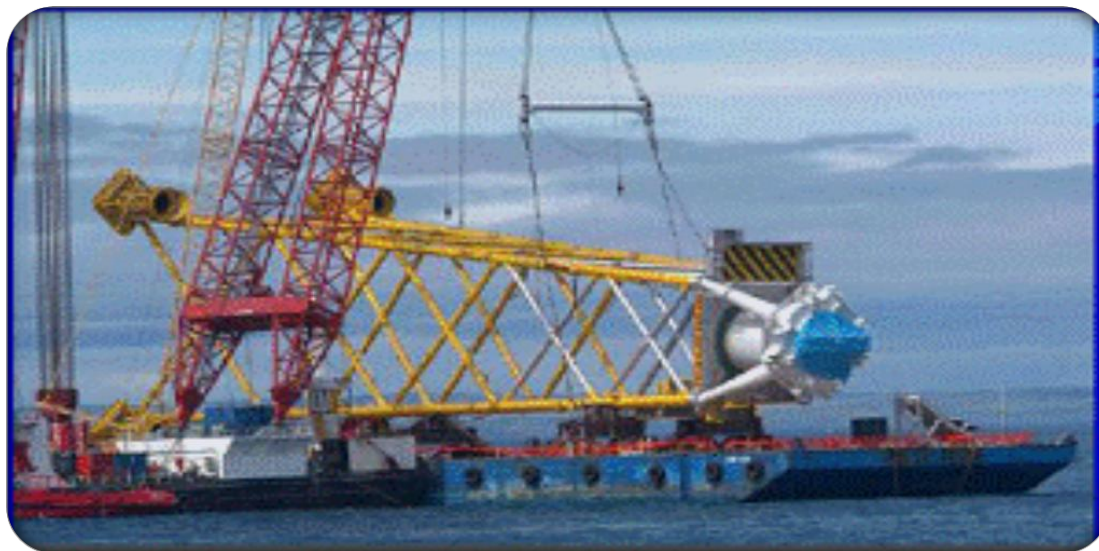
Εικόνα 3.7.5: Θεμελίωση με Μεταλλικό Τετράποδο.
