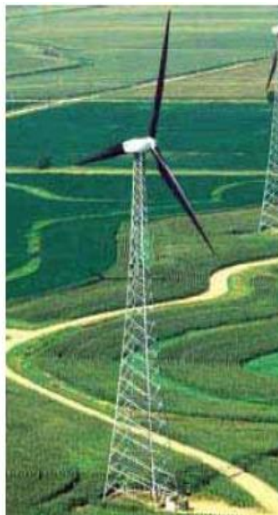
Εικόνα 3.2.3: Ανεμογεννήτριες με Χαλύβδινους και Δικτυωτούς πυλώνες αντίστοιχα.
