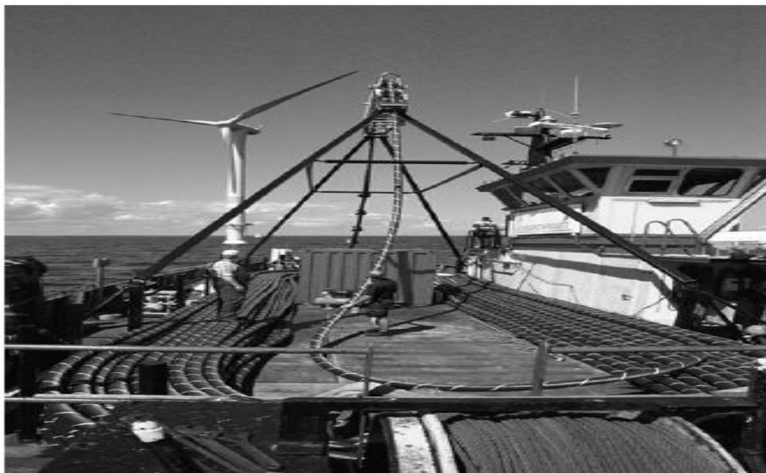
Εικόνα 6.1.5: Τοποθέτηση καλωδίων με ειδικό εξοπλισμό.
