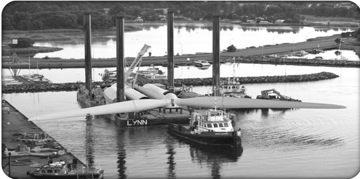
Εικόνα 3.9.1: Μεταφορά προσυναρμολογημένου στροφέα (70 μέτρα διάμετρος) για τοποθέτηση στο αιολικό πάρκο Yttre Stengrund.
