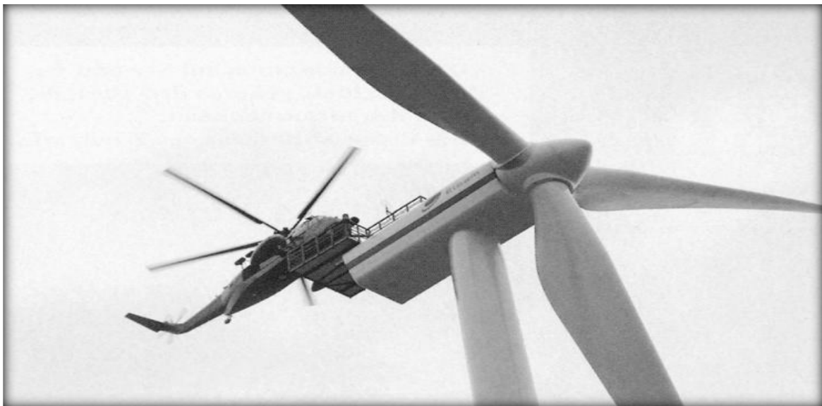
Εικόνα 3.6.2: Πλατφόρμα ελικοπτερου σε υπεράκτια ανεμογεννήτρια στο αιολικό πάρκο Horns Rev.
