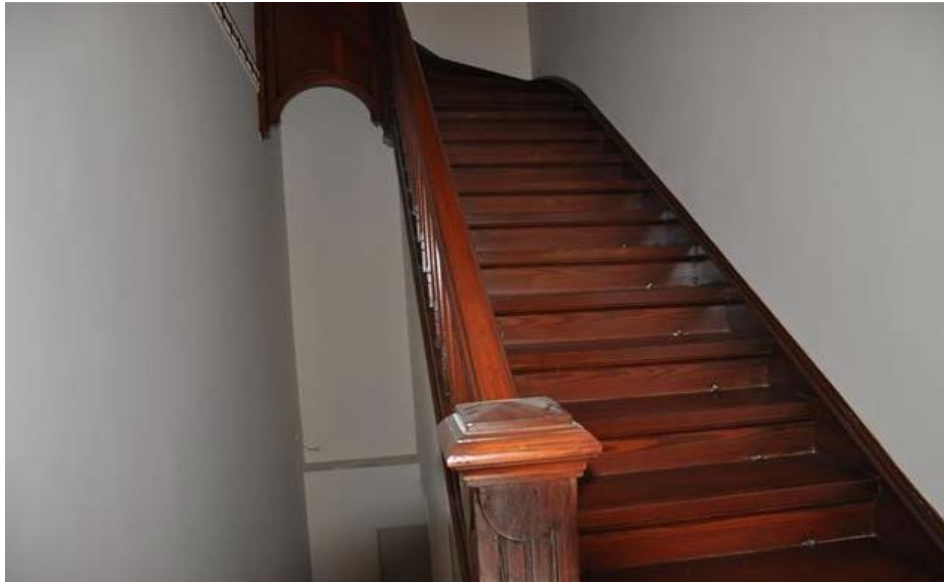
Εικόνα 9. Η ξύλινη σκάλα που οδηγεί στον όροφο του διατηρητέου.
