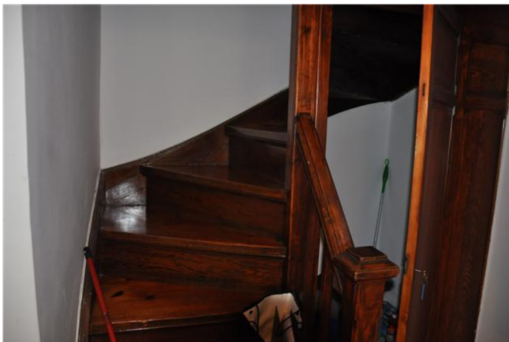
Εικόνα 14. Η σκάλα της κουζίνας του ορόφου που οδηγεί στο δώμα του κτιρίου. Να προσθέσουμε ότι αποτελεί και τη μόνη πρόσβαση του ορόφου με το δώμα. (8/06/2009)
