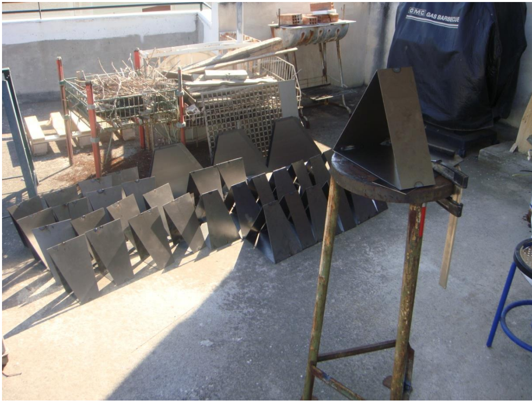
Φωτογραφία 6.5.1 Κατασκευή συνολικών υποτμημάτων.
