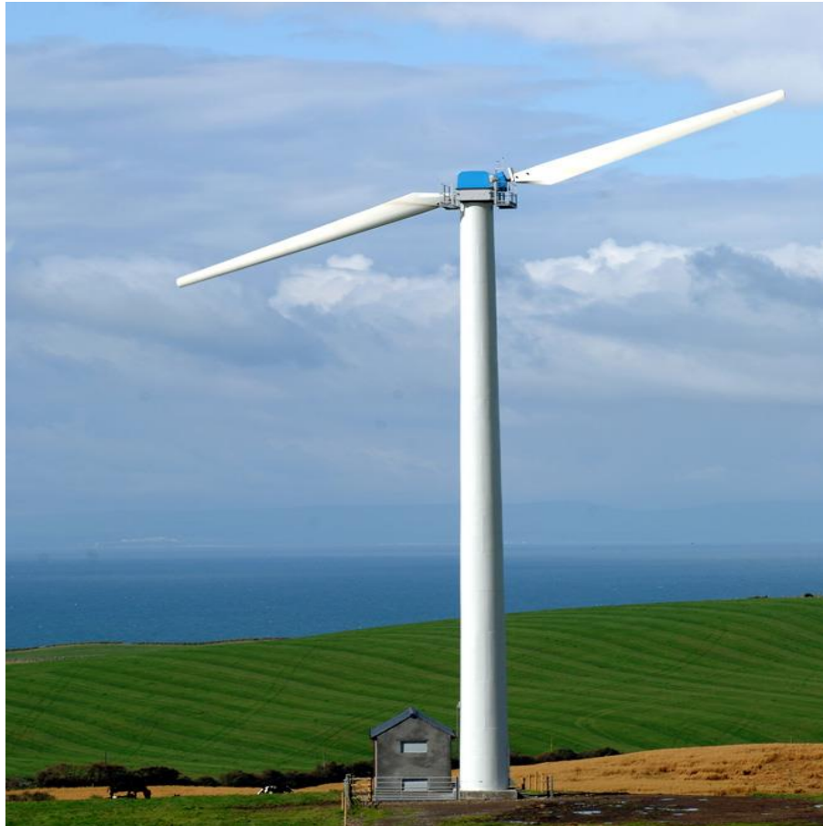
Φωτογραφία 4.3.2 Ανεμογεννήτρια οριζόντιου άξονα τύπου ΔΙΠΤΕΡΗ Πηγή www.windenergysolutions.nl
