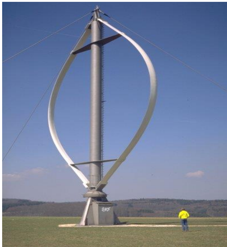
Φωτογραφία 4.1.5 Ανεμογεννήτρια κάθετου άξονα τύπου Darrieus Πηγή www.nesseq.com
