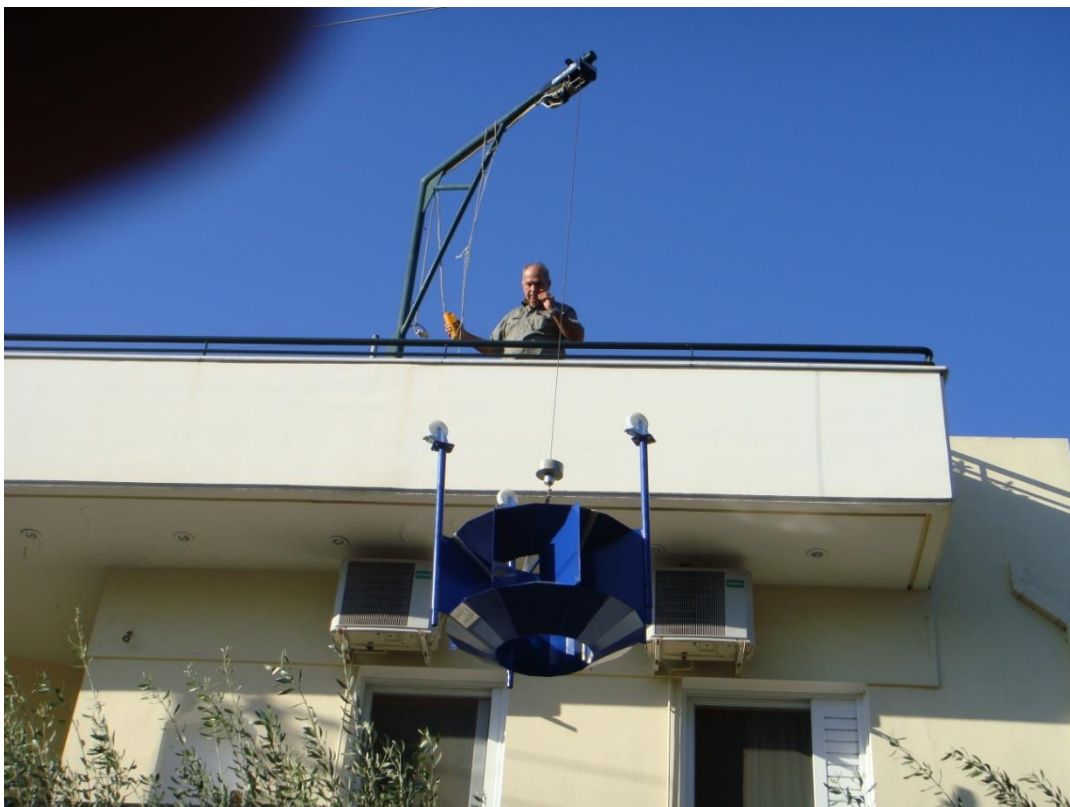
Φωτογραφία 6.4.2 Κατέβασμα Α/Γ με ηλεκτρικό γερανάκι.
