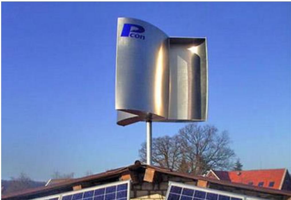
Φωτογραφία 4.1.5 Ανεμογεννήτρια κάθετου άξονα τύπου Savonius Πηγή www.ecosources.info
