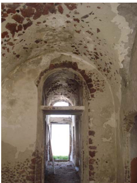
Εικ.31,32 - Ημικυλινδρική οροφή (Προσωπικό Υλικό)
