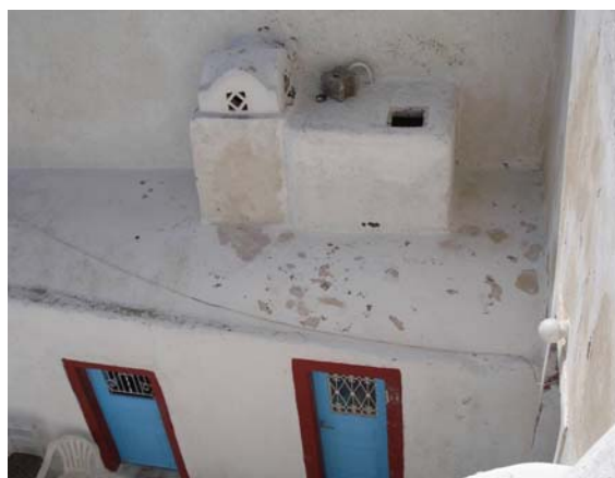
Εικ .28 - Φωταγωγός στην οροφή (Προσωπικό Υλικό)
