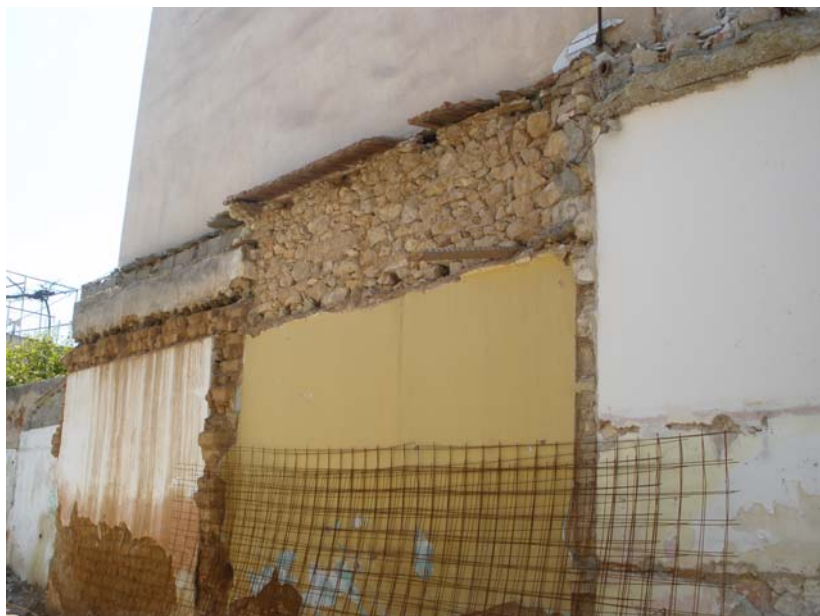
Εικ. Π.16 - Τοιχοποιία, υλικά (πέτρες, ξύλα, χώμα, φύλλα αλουμινίου)
