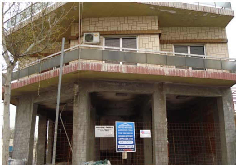
Εικ.97 – Στατική ενίσχυση (Προσωπικό Υλικό)
