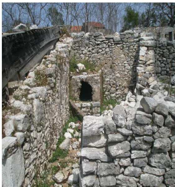
Εικόνα 17: ΠΕΤΡΙΝΟΣ ΦΟΥΡΝΟΣ ΜΕΣΑ ΣΤΗΝ ΚΟΥΖΙΝΑ ΚΑΤΟΙΚΙΑΣ
