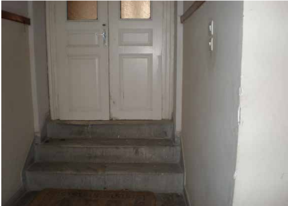
Εικόνα 9. Σκάλες που οδηγούν σε επίπεδο χαμηλότερο από του ισογείου
