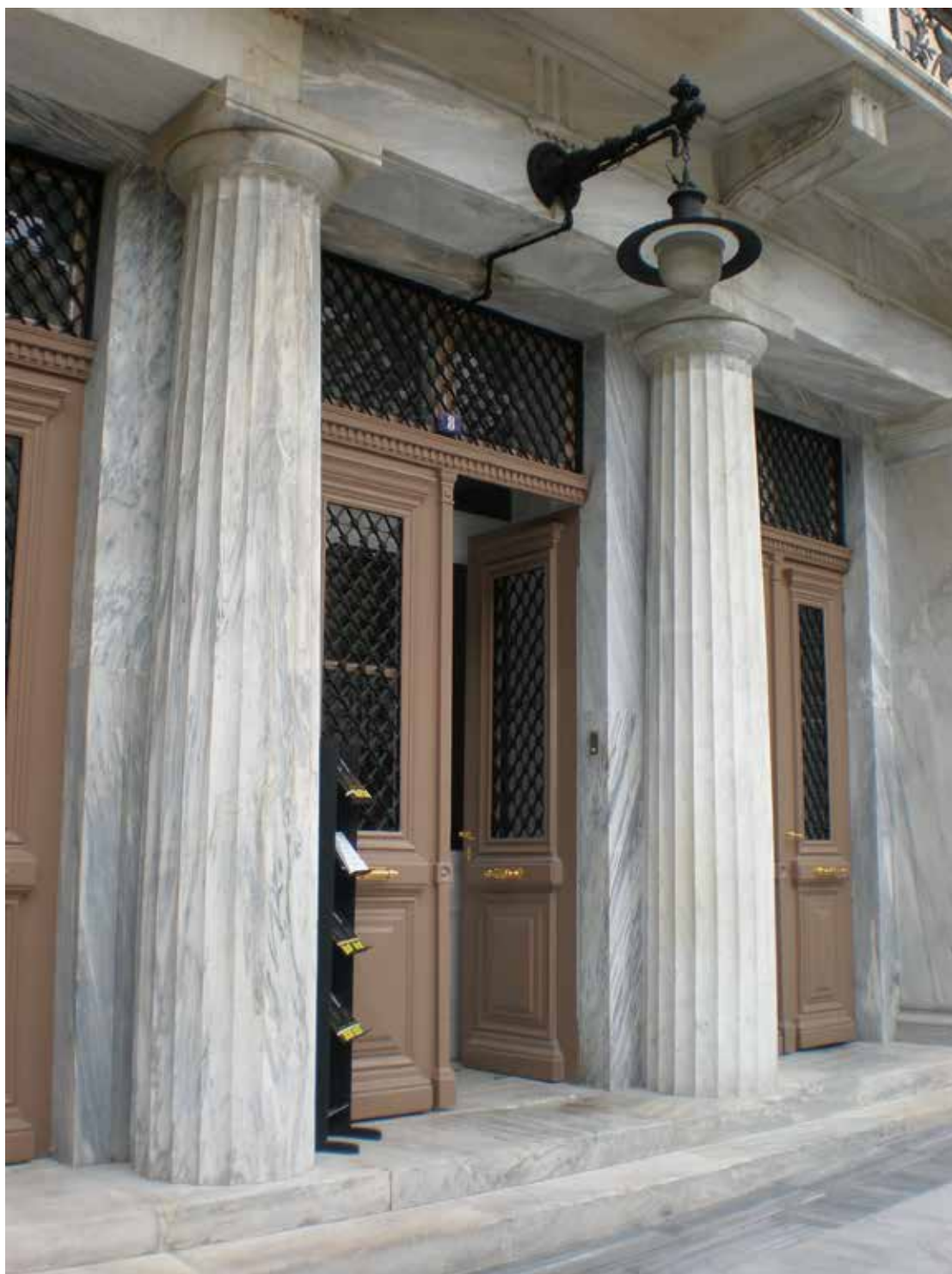
Εικόνα 41. Δωρικοί κίονες εισόδου
