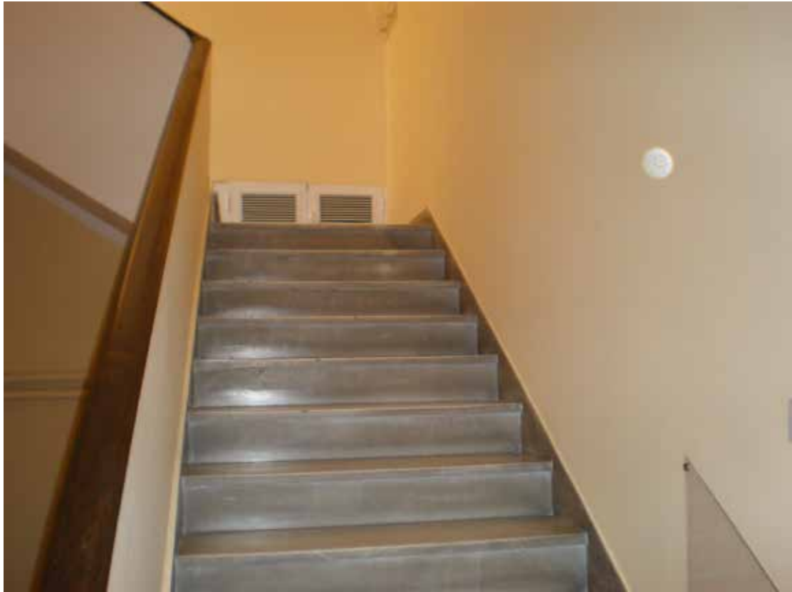
Εικόνα 36. Σκάλες που οδηγούν στο γ' όροφο
