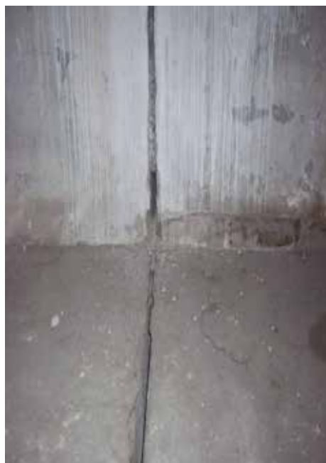
Εικόνες 7,8: Οι στατικοί αρμοί του κτιρίου
