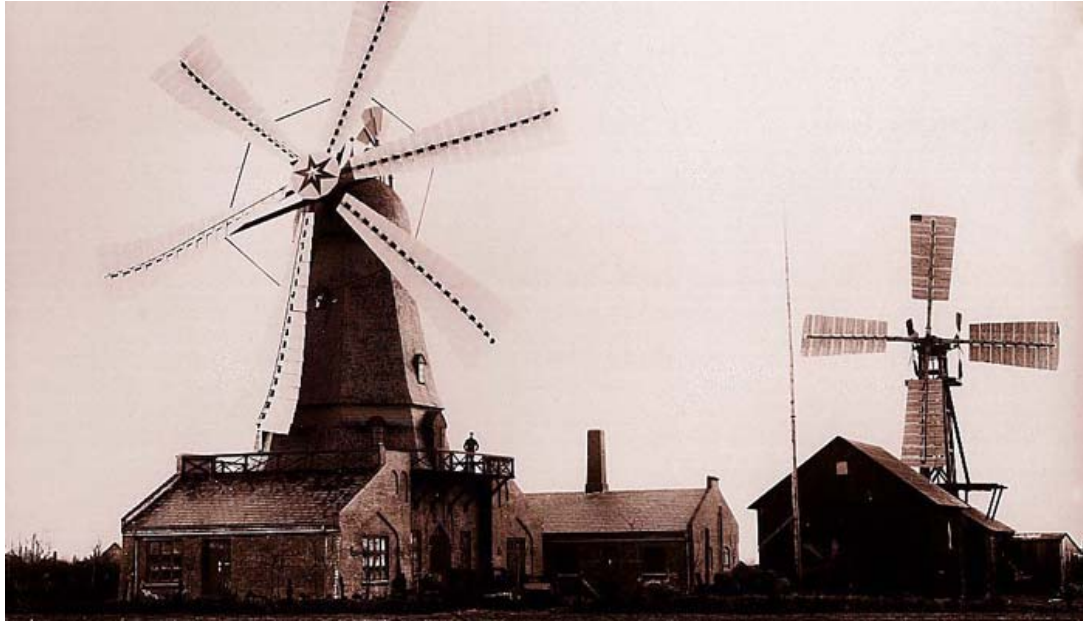
Εικόνα 3.1 Δυο από τις πρώτες ανεμογεννήτριες που χρησιμοποιήθηκαν για ερευνητικά τεστ το 1897 στο Askon της Δανίας κατασκευασμένα από το μετεωρολόγο RoullaCour που θεωρείται πρωτοπόρος στην αιολική ενέργεια
