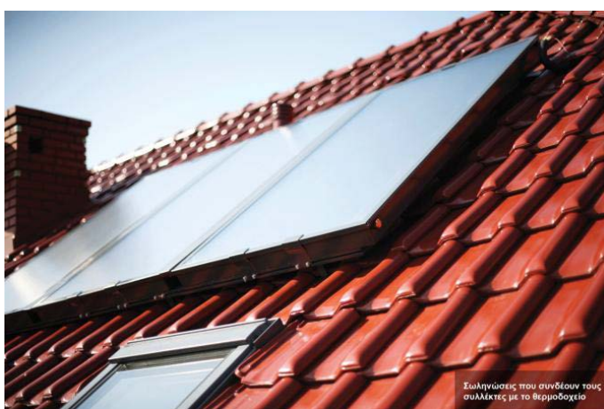
Σχήμα 34 Εγκατάσταση επίπεδου ηλιακού συλλέκτη σε κεκλιμένη στέγη (Τσαρτσάλης, 2012)
