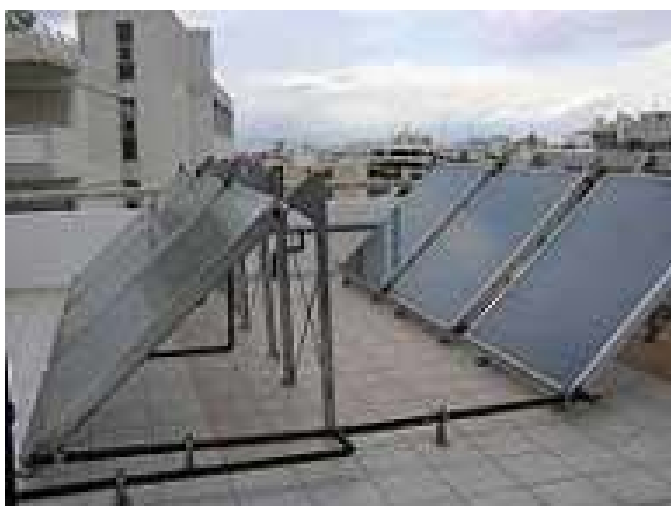
Σχήμα 33 Εγκατάσταση επίπεδου ηλιακού συλλέκτη σε οριζόντια στέγη (Τσαρτσάλης, 2012)
