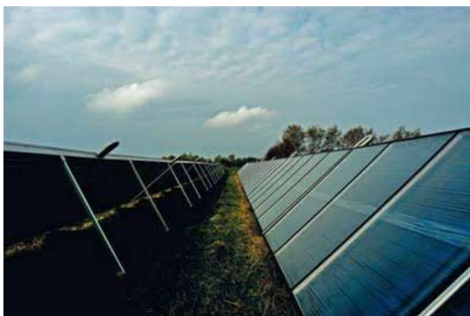
Σχήμα 32 Εγκατάσταση επίπεδου ηλιακού συλλέκτη στο έδαφος (Τσαρτσάλης, 2012)
