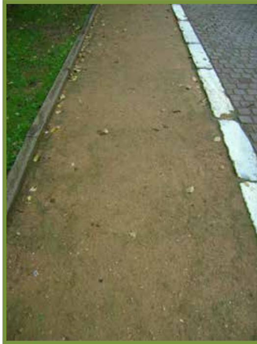
Εικ.60 Χωμάτινο Πεζοδρόμιο
