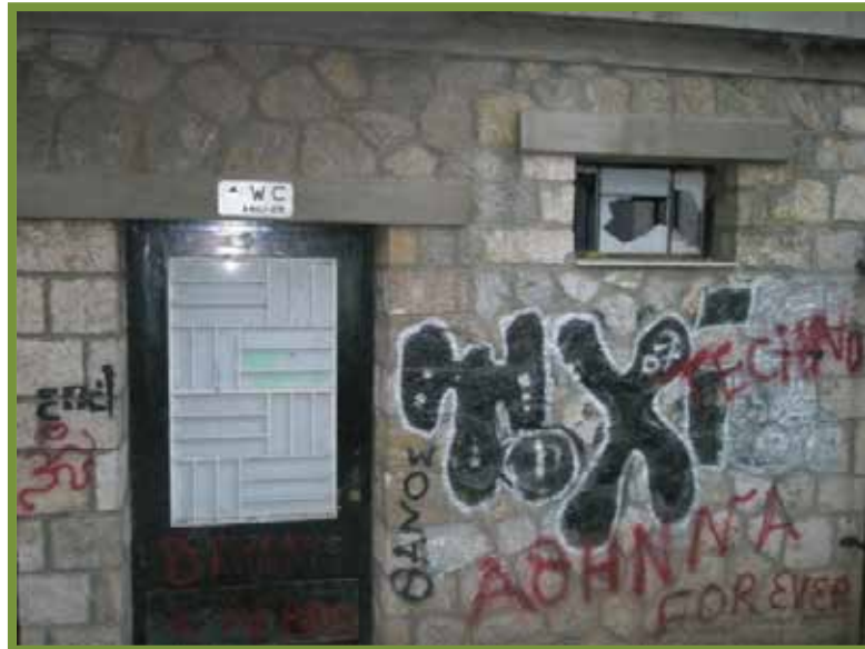
Εικ.38 Το κτίριο των Δημόσιων Αποχωρητηρίων στο Πεδίο.
