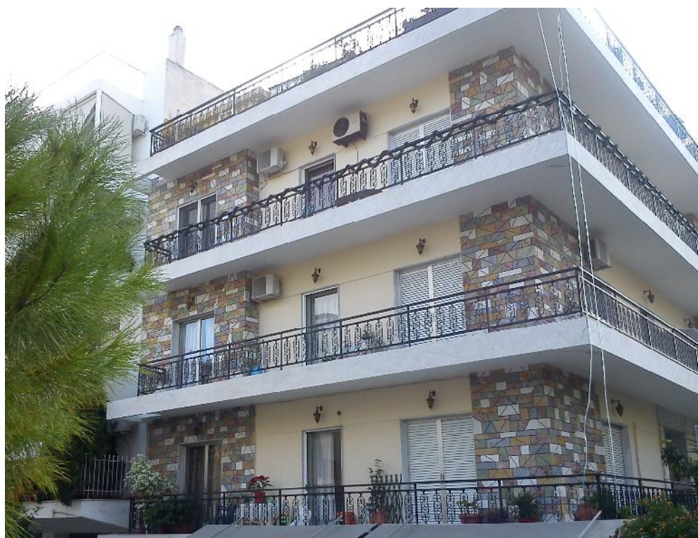
Εικόνα 1.3.: Υπάρχουσα κατάσταση του κτιρίου 3
