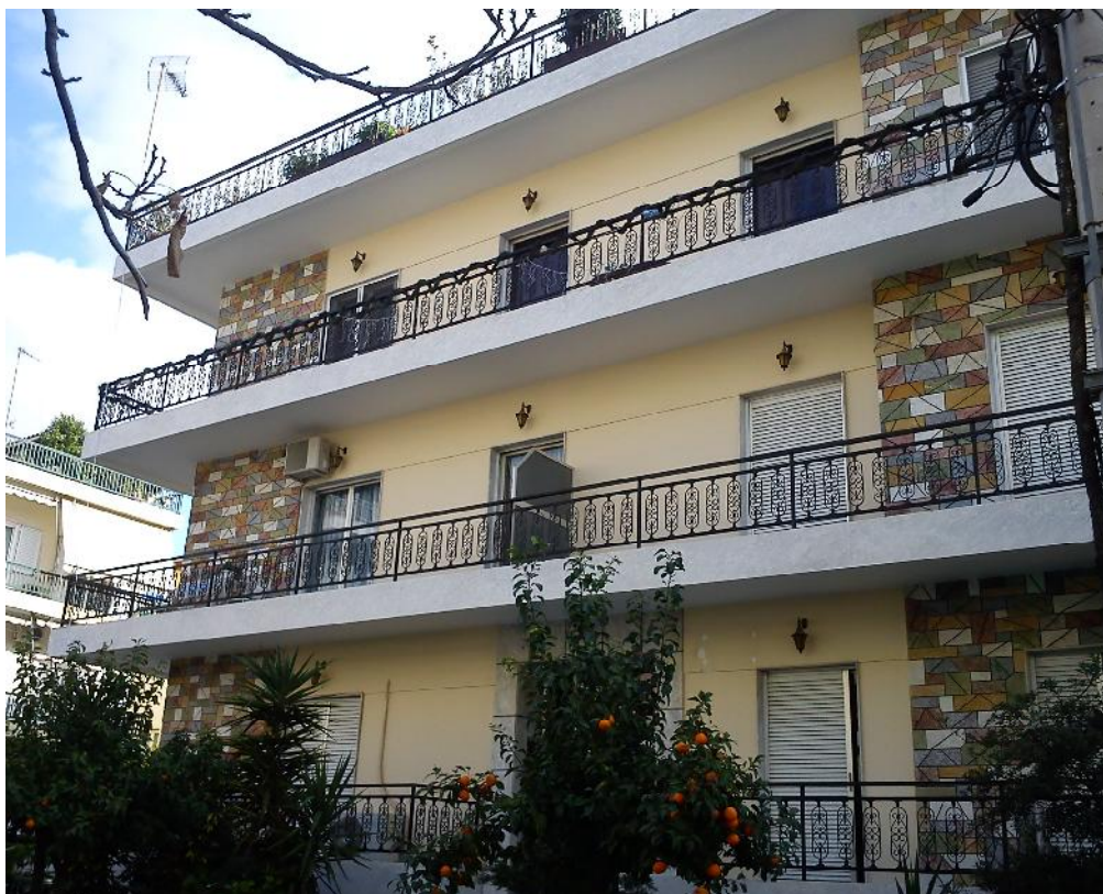
Εικόνα 1.2.: Υπάρχουσα κατάσταση του κτιρίου 2
