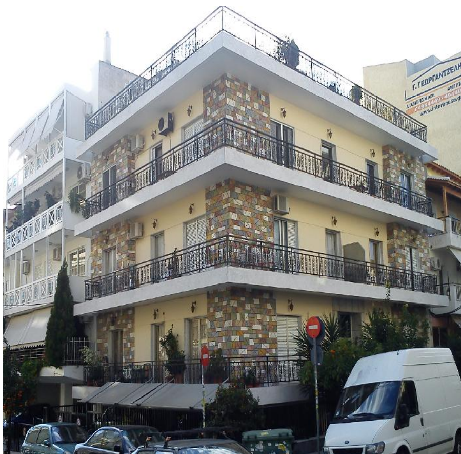
Εικόνα 1.1.: Υπάρχουσα κατάσταση του κτιρίου 1
