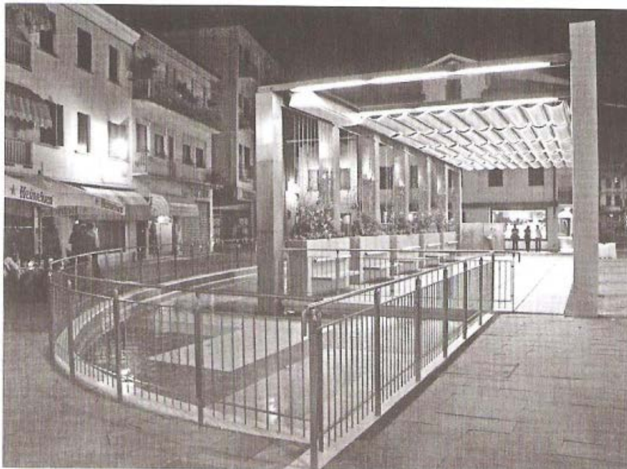
Σχ.49 Πέργκολα κατασκευασμένη από σπλισμένο σκυρόδεμα, ξύλο και ύφασμα. Motta di Livenza, Italia
