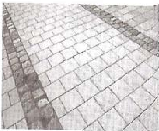
Σχ.37 Δάπεδο από φυσικούς και τεχνητούς κυβόλιθους Διαμορφώσεις δαπέδων των ανεξάρτητων πεζοδρόμων από τον Δ. Πικιώνη στο Φιλοπάππου. Διακρίνονται τα ενδιαφέροντα μορφολογικά αποτελέσματα με την επιτυχημένη συνθετική και οικοδομική επιδαπέδια χρήση των φυσικών λίθων και του πλυμένου μπετόν.
