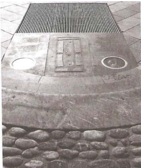
Σχ.46 Ενδοδαπέδια φωτιστικά αριστερά και επιδαπέδια δεξιά Hauptplatz,, Leoben Austria
