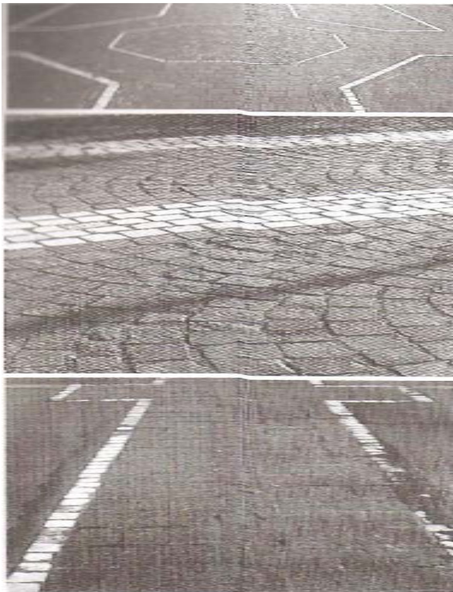
Σχ. 36 Δάπεδο από φυσικούς και τεχνητούς κυβόλιθους
