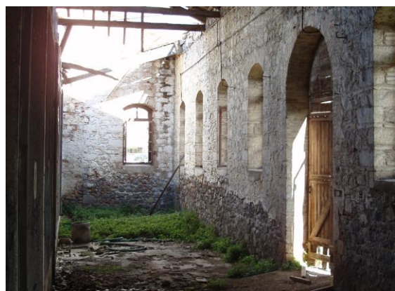
Φωτ.24 - Ισόγειος αποθηκευτικός χώρος
