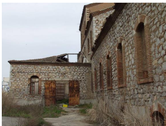
Φωτ.28 – Μεταγενέστερη προσθήκη κτιρίου
