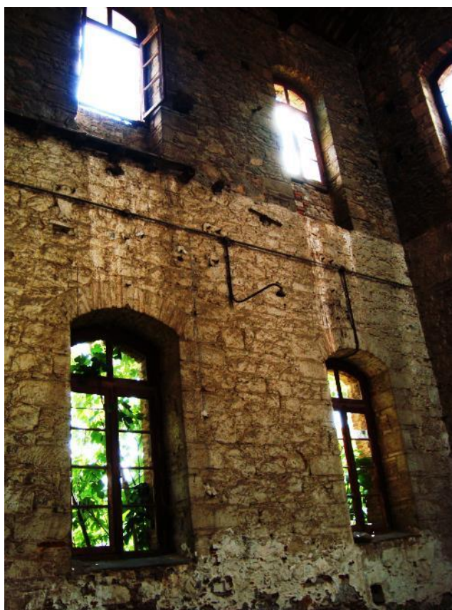
Φωτ.33 – Το εσωτερικό του κτιρίου
