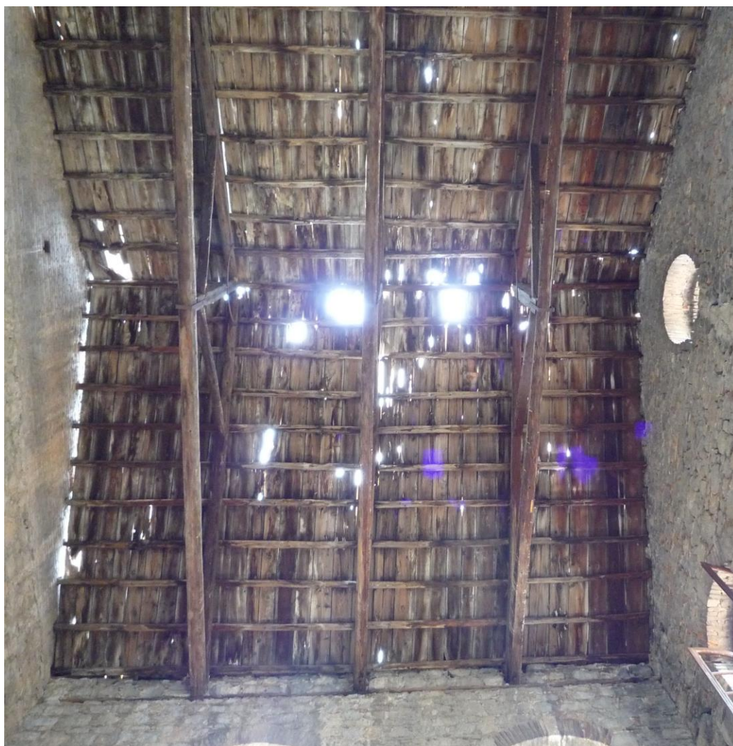
Φωτ.31 – Άποψη της στέγης του υπάρχοντος κτιρίου
