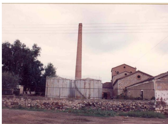
Φωτ.18 - Μεταγενέστερη προσθήκη 8 μεταλλικών δεξαμενών το 1973
