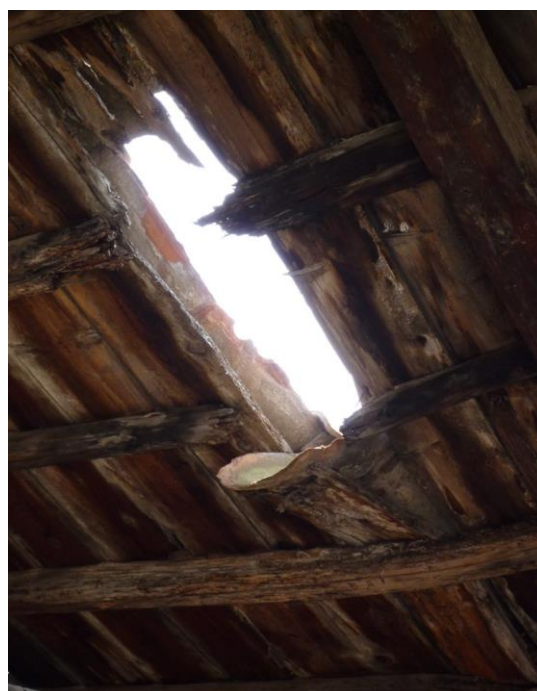
Φωτ.29/30 – Η στέγη του υπάρχοντος κτιρίου
