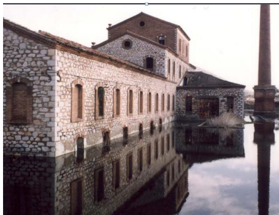
Φωτ.41 – Τα λιμνάζοντα ύδατα στο πίσω μέρος του κτιρίου
