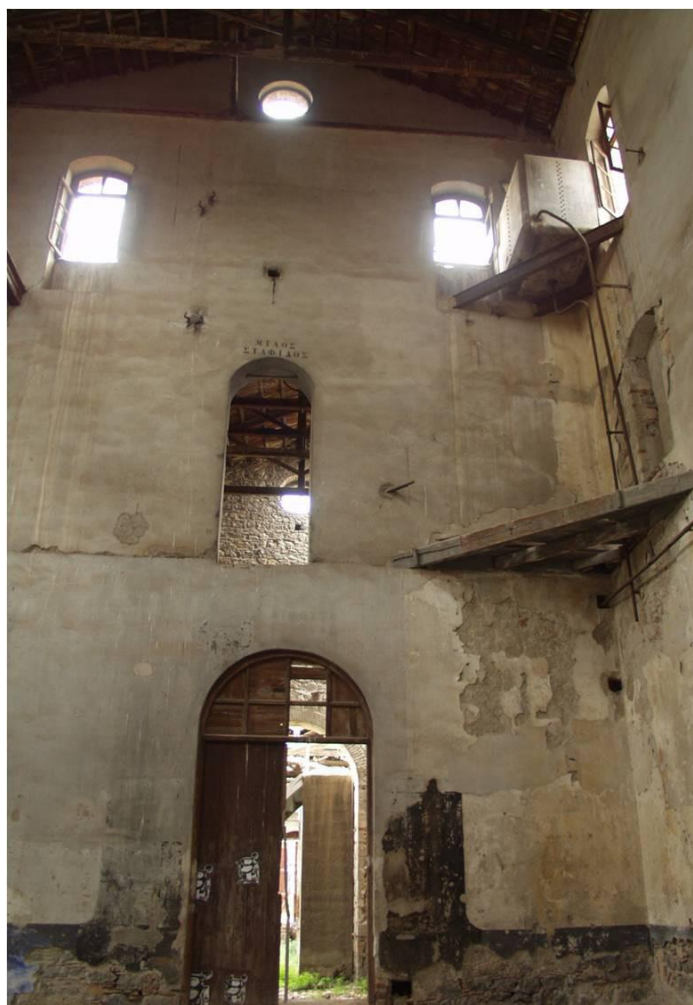
Φωτ.42 - Κεντρικός χώρος αποστακτηρίου, μεταλλικές δοκοί ωφελούν την σύνδεση των γωνιών των τοιχοποιιών
