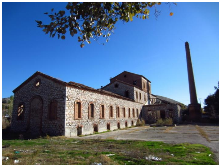
Φωτ.13 - Το κτίριο έτσι όπως σώζεται
