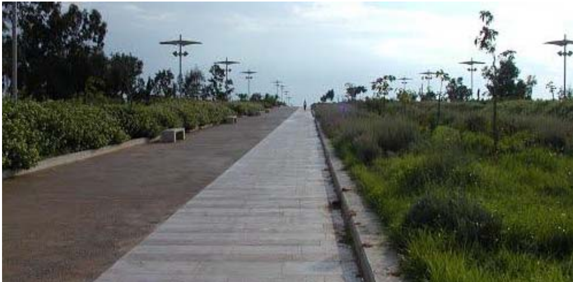
Εικόνα 46 Κατά μήκος της γέφυρας
