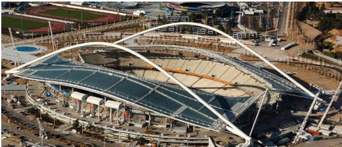
Εικόνα 10 Ολυμπιακό Αθλητικό Κέντρο Αθήνας Η στέγη του Ολυμπιακού Σταδίου έχει συνολική επιφάνεια σε κάτοψη περίπου 25.000 μ 2 .
