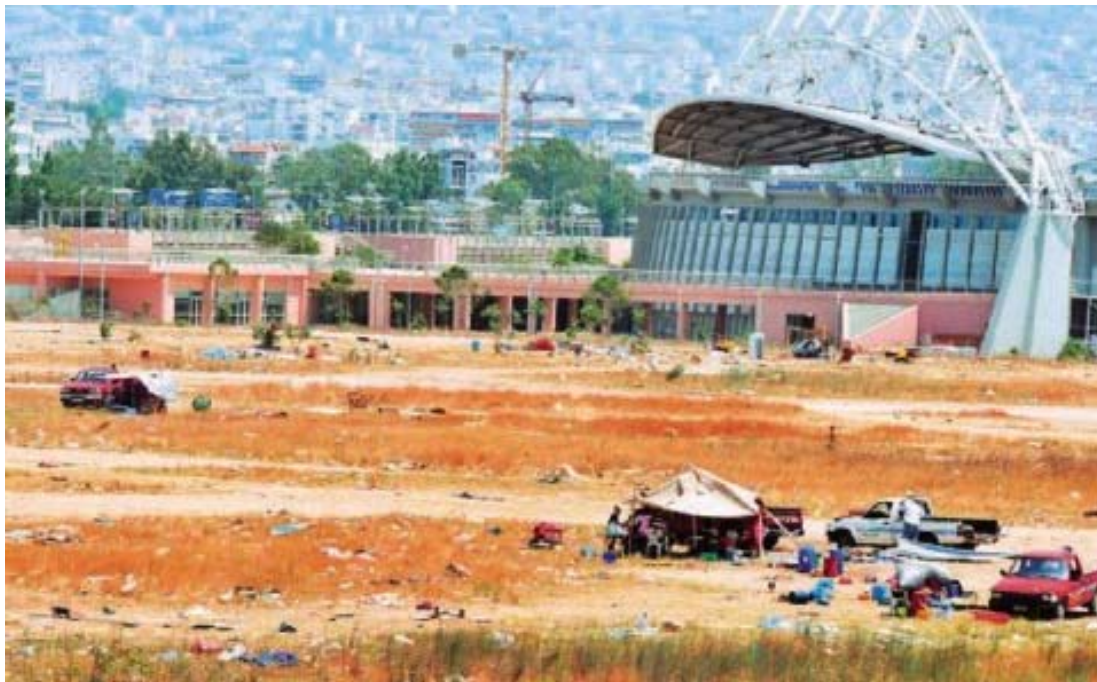
Εικόνα 60 Η υφιστάμενη κατάσταση της εν λόγω περιοχής
