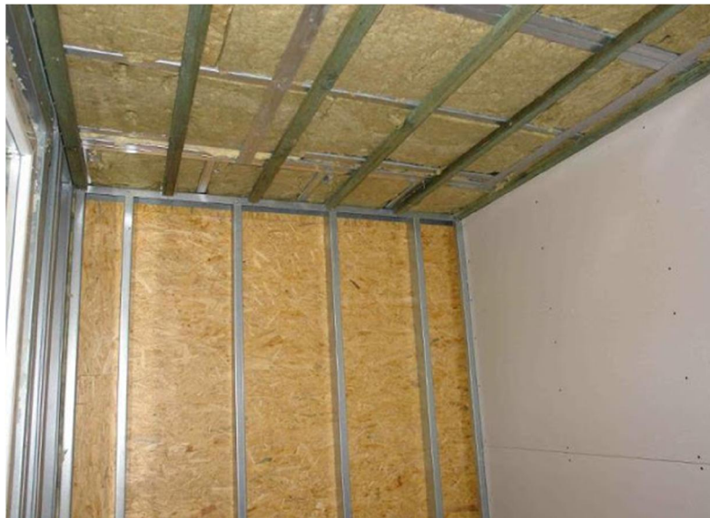
μεταλλικός σκελετός και τοιχοποιία με osb πλάκες
