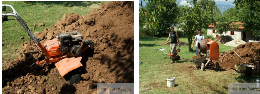
Φρεζάρισμα –ανακάτεμα χώματος
