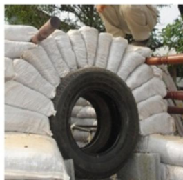
Εικόνα 1:Τοξωτό παράθυρο με τη βοήθεια ρόδας
