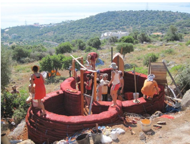
Τοποθέτηση ανοιγμάτων
