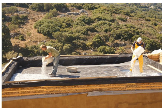
Μόνωση δώματος με πισσόχαρτα και εργασίες κατασκευής φυτεμένης στέγης
