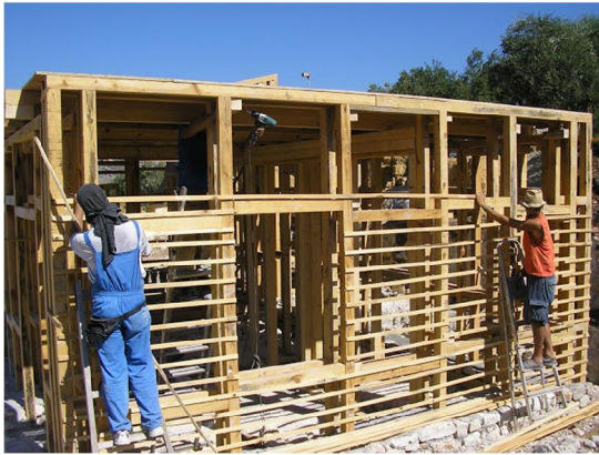
Οριζόντια τοποθέτηση ξύλινων πηκακίων
