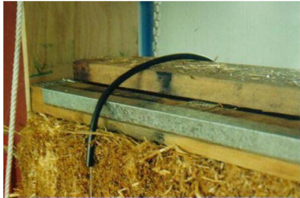
Προβολή κορυφής πλάκας συναρμολόγησης δείχνοντας το συρμάτινο βρόχο
