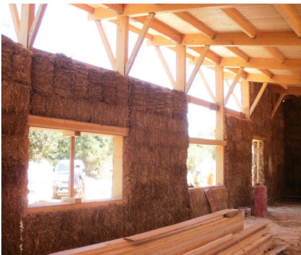
τεχνική 2 η : Αχυρόμπαλες ως γέμισμα τοιχοποιίας
