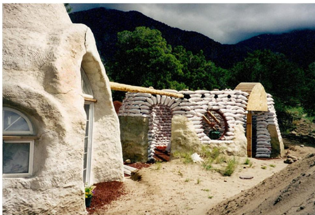
Το υπό κατασκευή σπίτι με γαιόσακους του Kelly Hart
