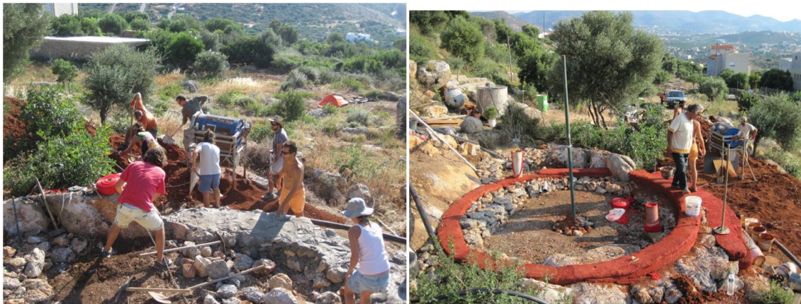
Θεμελίωση βάθους 40-50 εκ.
