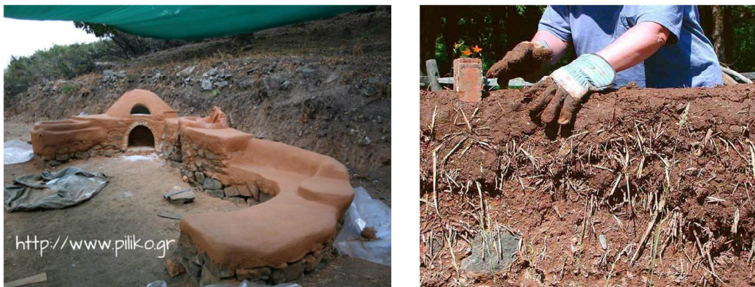
Κατασκευή τοίχου κόμπ (πηγή: http://en.wikipedia.org/wiki/Cob )
