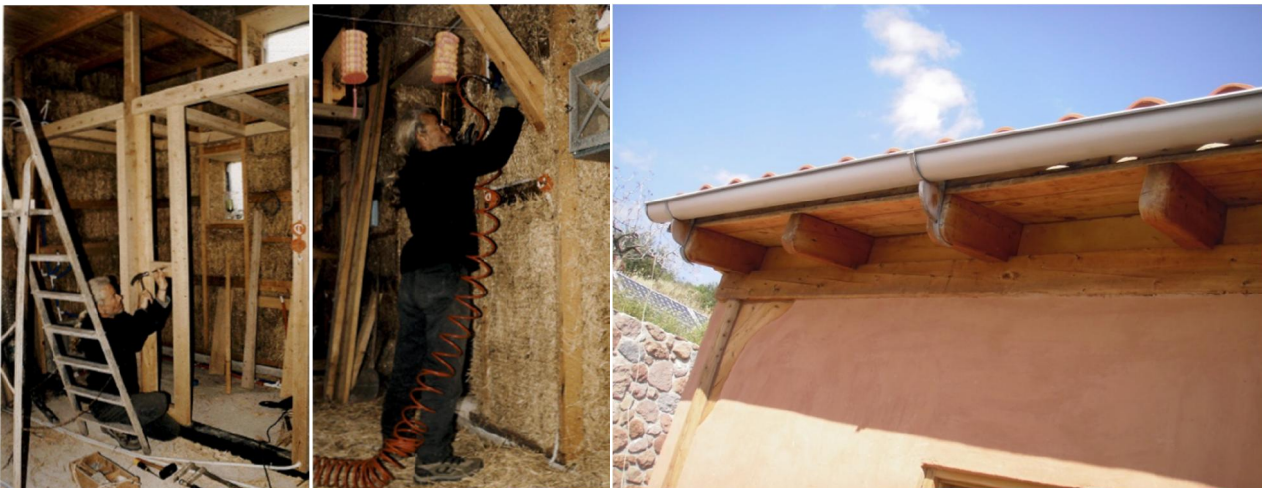
Τοποθετήθηκαν από τους ιδιοκτήτες οι ηλεκτρικές /υδραυλικές εγκαταστάσεις (βλ. κάτω εικόνες)
