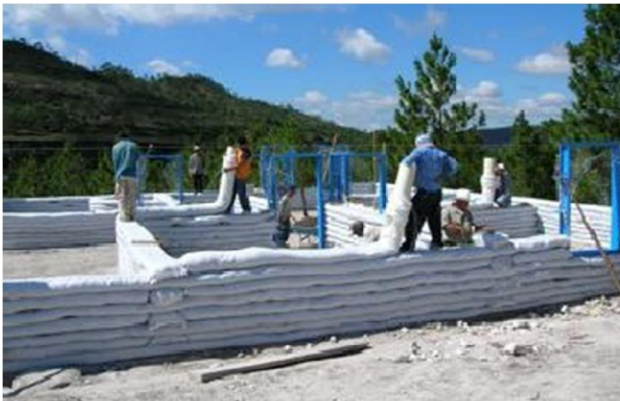
Κατασκευή Earthbag με Σωλήνες 5 , σάκους & λινάτσα
