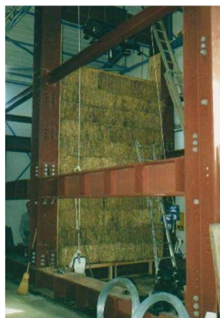
Γενική άποψη του πλαισίου δοκιμής χάλυβα και ημιτελής τοίχος
