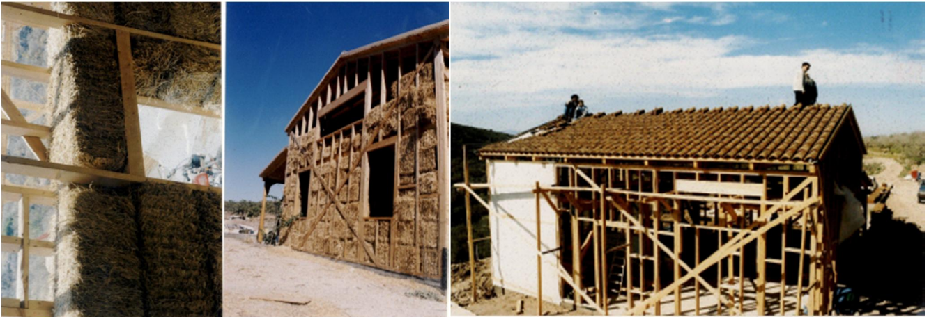
Τοποθέτηση κεραμιδιών , γέμισμα αχυρόμπαλων στη τοιχοποιία (πηγή : Προσωπικό αρχείο ιδιοκτήτη)
