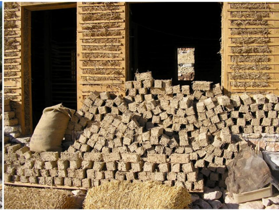
Τοποθέτηση Ωμόπλινθων στη πρόσοψη του κτιρίου
