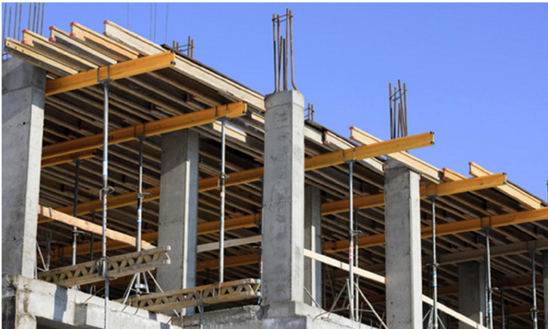
καλούπωμα με ξύλα για την κατασκευή πλάκας ( http://www.buildnet.gr/default.asp?pid=193&catid=168&artid=1178 )
