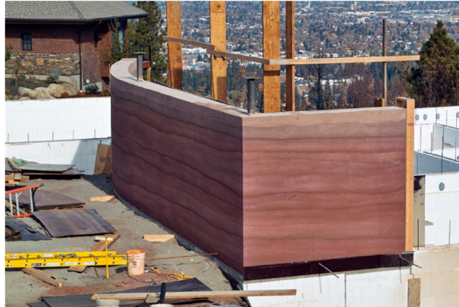
κατασκευή rammed earth τοίχου (πηγή: www.flickr.com )
