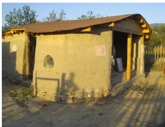
Ολοκλήρωση τοιχοποιίας κομπ και ξύλινης στέγης
