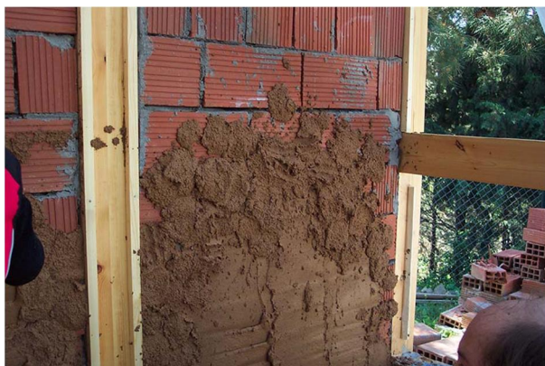
Πρώτη Στρώση – έχει προηγηθεί βρέξιμο του τοίχου
