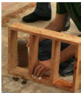
Εικόνα 1: Αλοιφή καλουπιού με λινόλαιο
