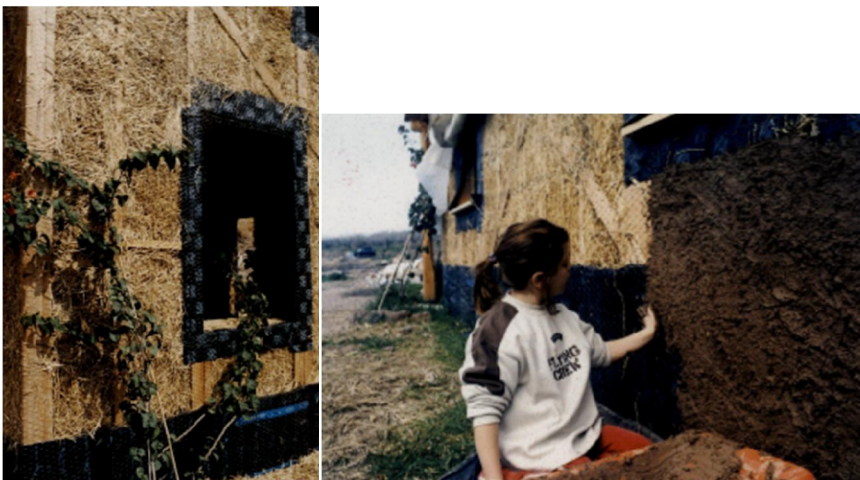
Πισσόχαρτα σε ανοίγματα –πρώτη στρώση σοβά-πεταχτού
