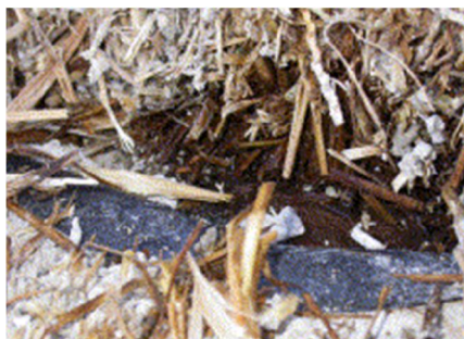
Εικόνα 1 : Άχυρο πίσω από τοίχο που διατηρείται σε συνθήκες υψηλής υγρασίας (πηγή: http://www.sciencedirect.com )
