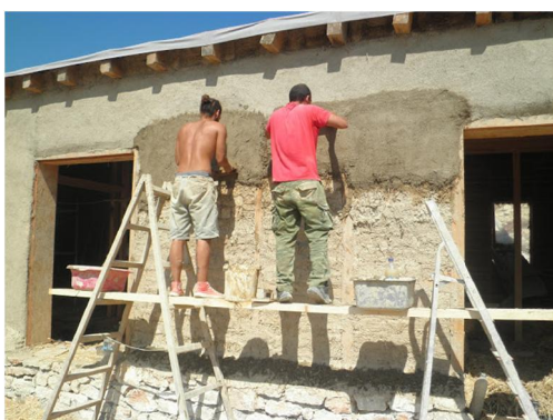
Εξωτερική επίστρωση σοβά
