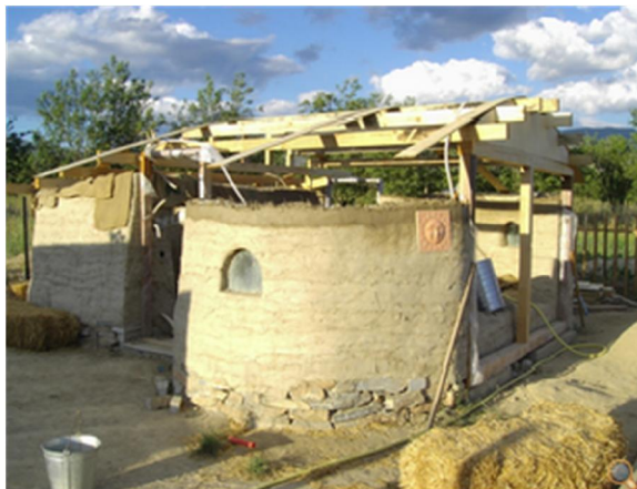
Το υπό κατασκευή σπίτι κομπ στο χωριό Νέσσωνα Λάρισας (πηγή : www.cob.gr )
