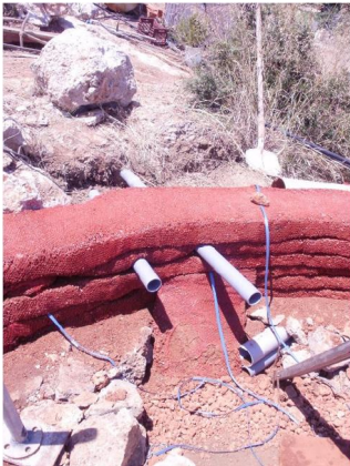
Προσθήκη υδραυλικών εγκαταστάσεων
