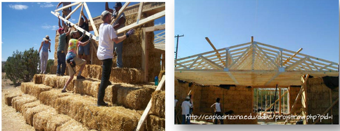
Τοποθέτηση στέγης –ξύλινου ζευκτού
