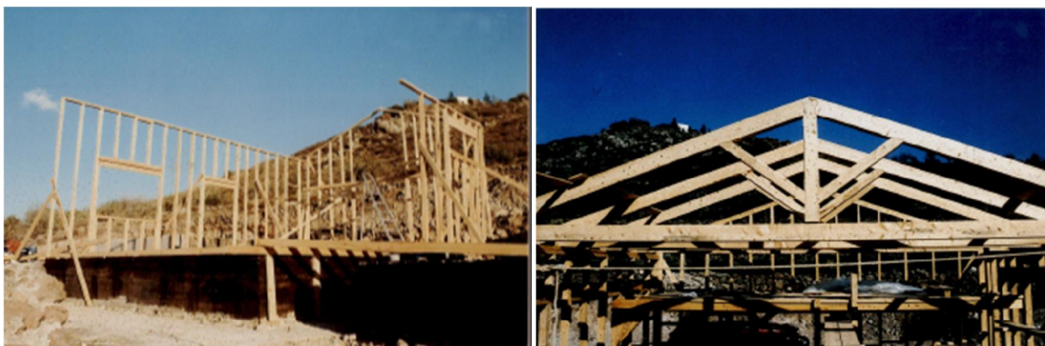
Ξύλινος προκατασκευασμένος σκελετός, ζευκτά στέγης (πηγή: Προσωπικό Αρχείο ιδιοκτήτη)
