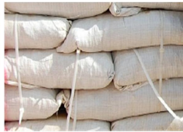
Κατασκευή Earthbag με Σωλήνες 5 , σάκους & λινάτσα
