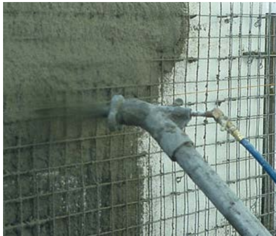
Εικόνα 23 Χρήση εκτοξευόμενου σκυροδέματος
