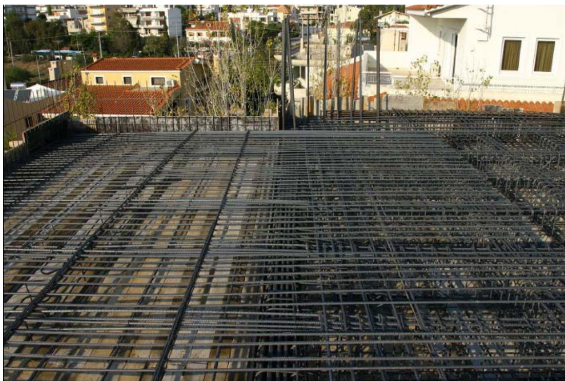
Εικόνα 15 Σιδέρωμα πλάκας
