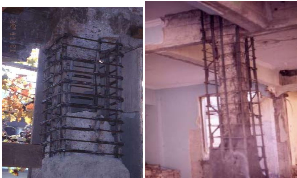
Εικόνα 21 Ενίσχυση υποστυλωμάτων με μανδύες από Ο.Σ.
