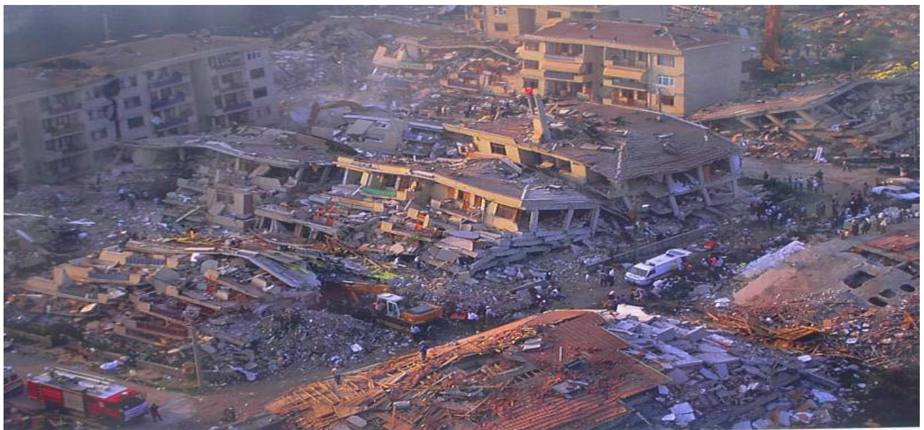
Εικόνα: Καταστροφή της πόλης Izmit –Τουρκία από τον σεισμό του 1999
