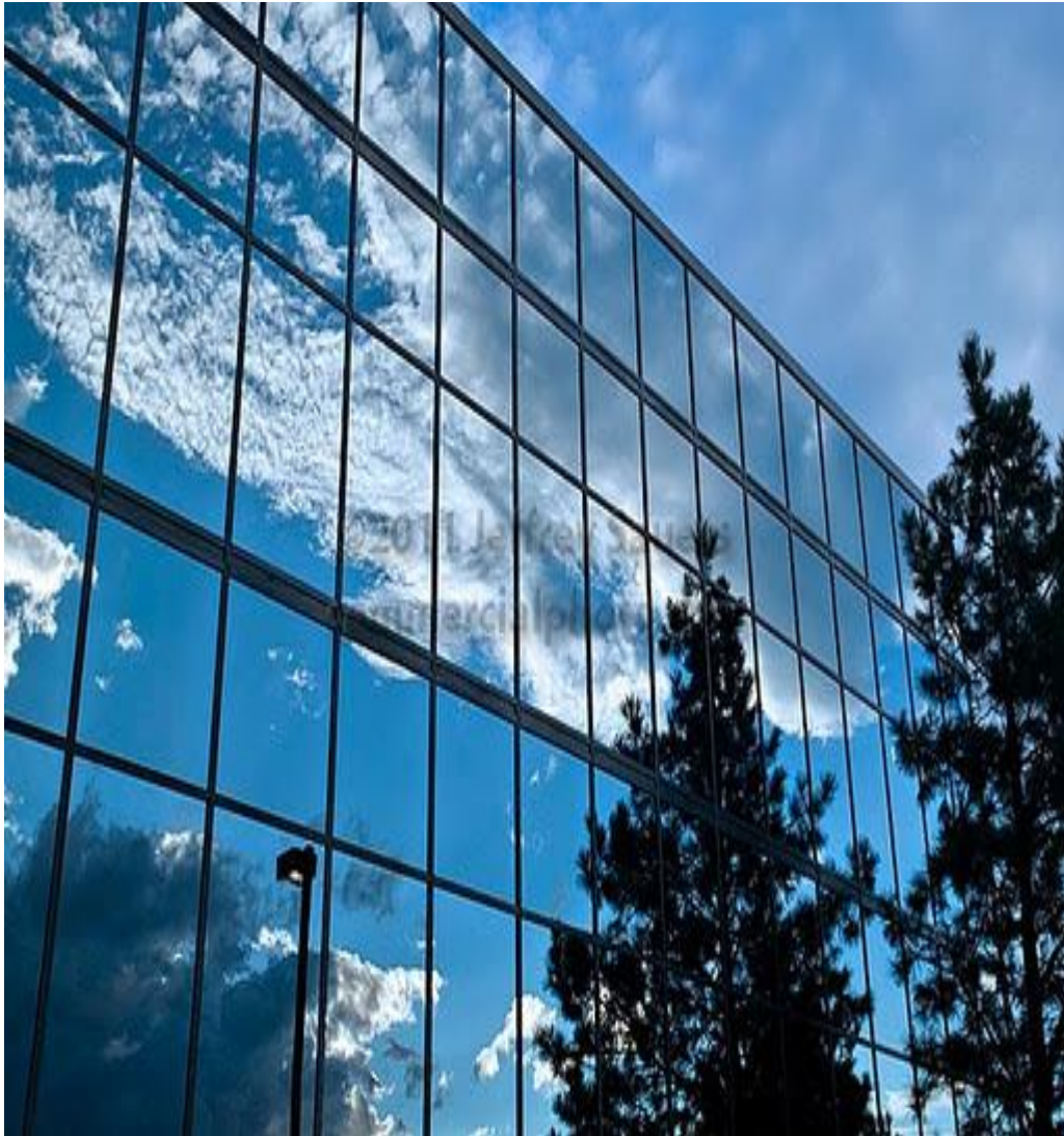
Εικόνα 22 Όψη κτιρίου με ειδικά κρύσταλλα (πηγή: www.learnmephotography.wordpress.com )
