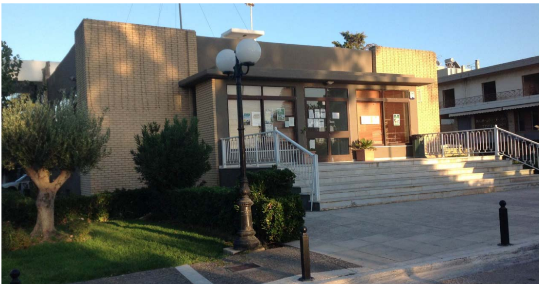
Εικόνα 47 Η πρόσοψη του κτιρίου, (δυτική πλευρά)
