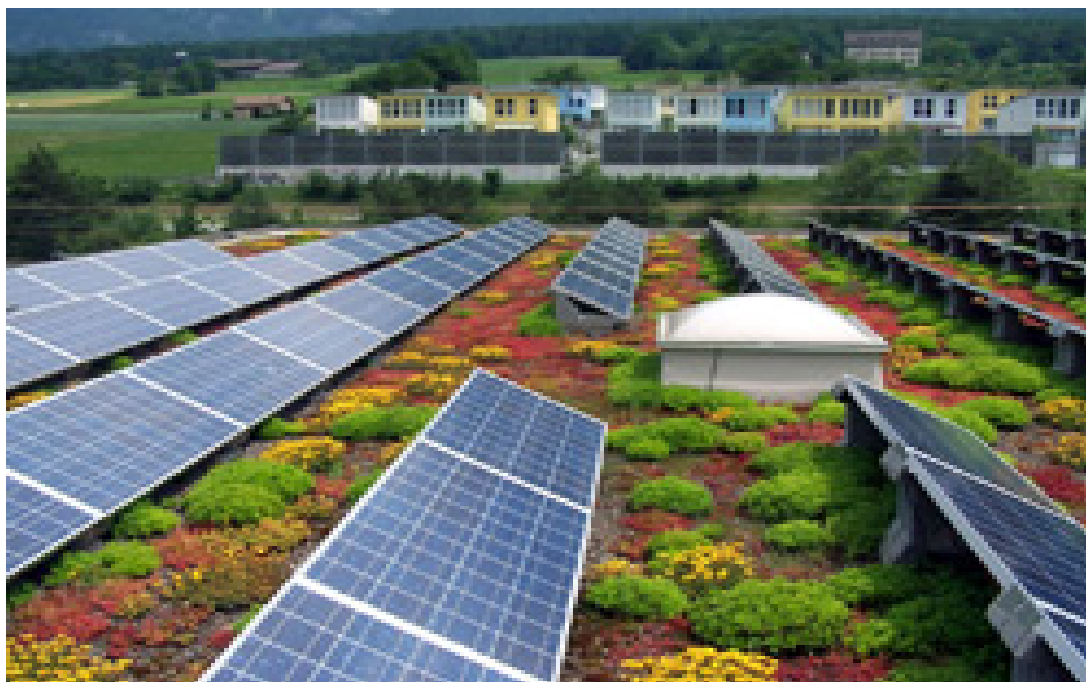
Εικόνα 23 Εκτατικός τύπος φυτεμένου δώματος
