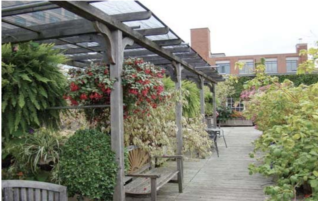
Εικόνα 21 Εντατικός τύπος φυτεμένου δώματος
