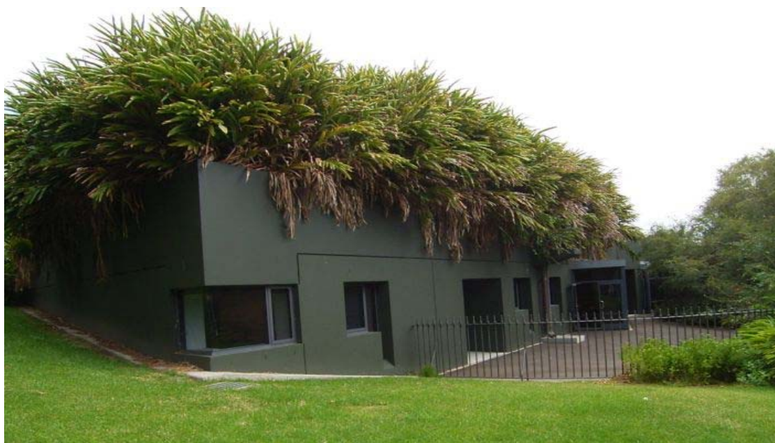
Εικόνα 22 Ημιεντατικός τύπος φυτεμένου δώματος
