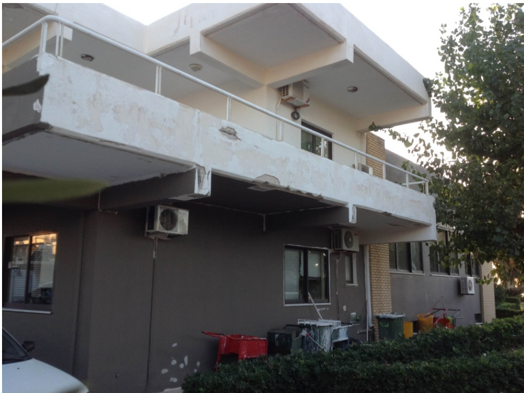
Εικόνα 34 Η δυτική πλευρά του κτιρίου
