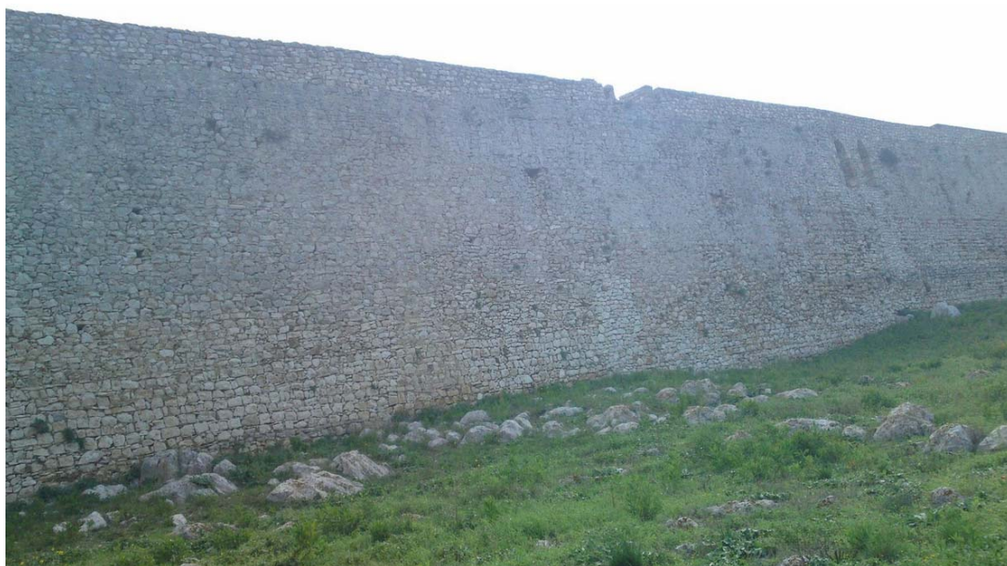
Εικόνα 57 Η νότια πλευρά του εξωτερικού τοίχου
