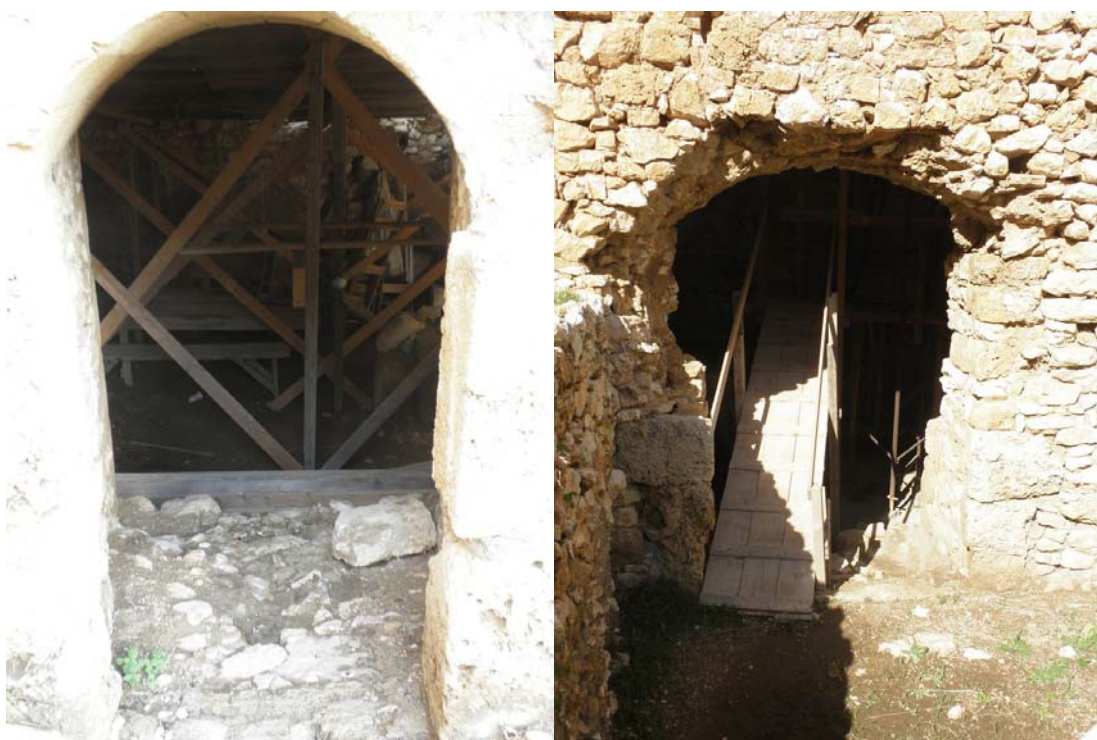
Εικόνα 40 Εργασίες αναστήλωσης στο κτίριο A1
