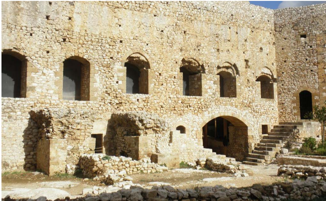
Εικόνα 24 Κατά μήκος των κτιρίων έχουν κατασκευαστεί συμμετρικά ανοίγματα βλέπουν στην εσωτερική αυλή
