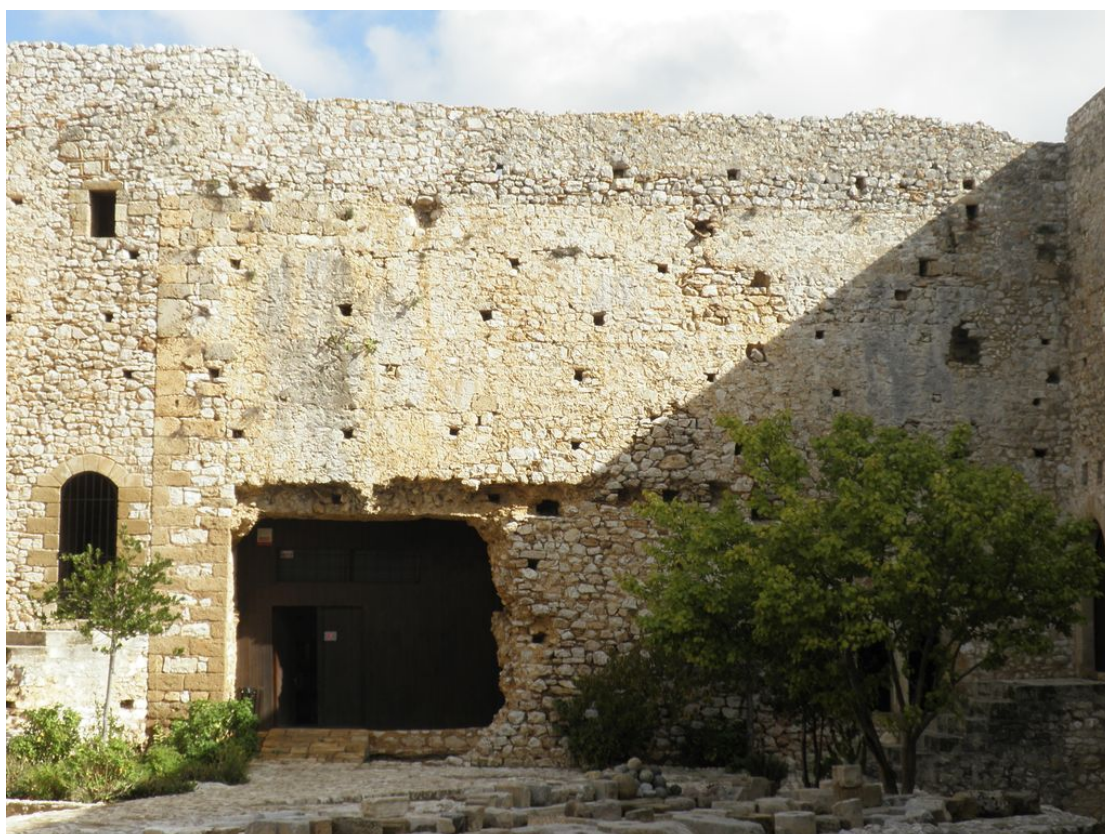
Εικόνα 54 Η είσοδος προς το κτίριο A5
