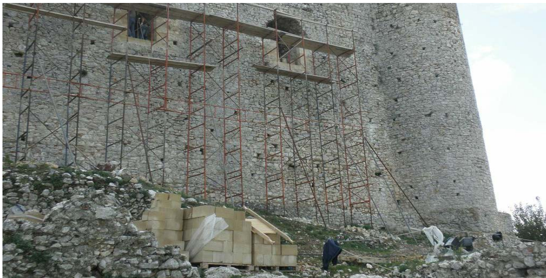
Εικόνα 41 Εργασίες αναστήλωσης εξωτερικά του κάστρου
