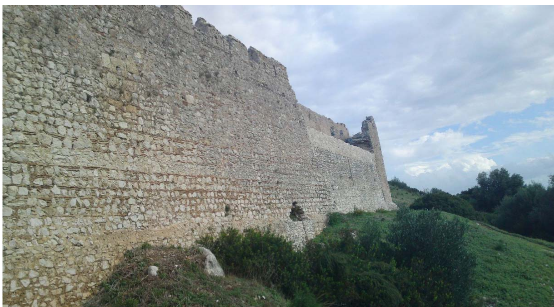
Εικόνα 58 Η συνέχεια της νότιας πλευράς του εξωτερικού τοίχου
