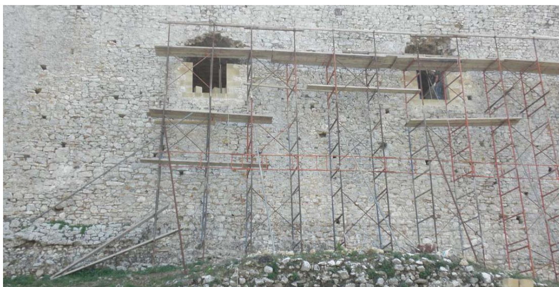
Εικόνα 36 Εξωτερικά του κτιρίου πραγματοποιούνται επεμβάσεις ανάπλασης του
