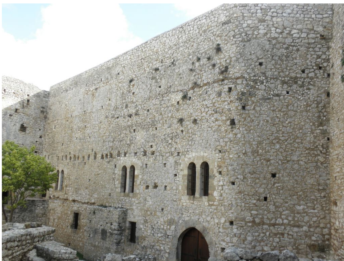
Εικόνα 53 Εξωτερικά του κτιρίου Α5
