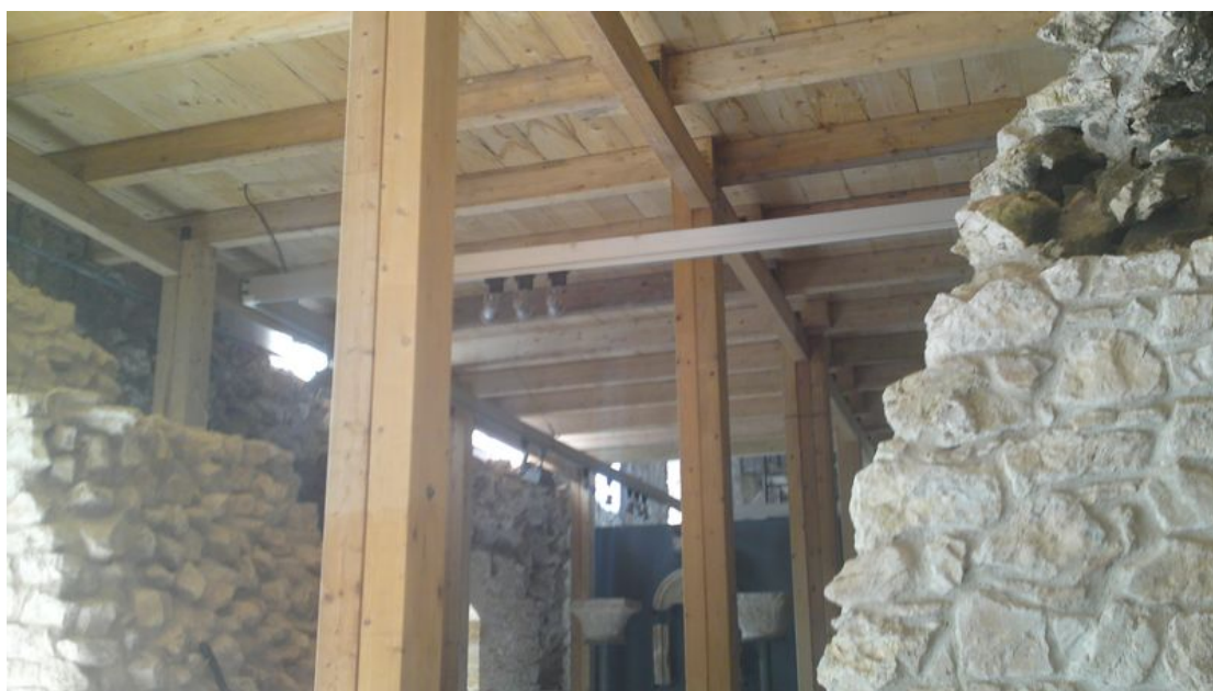
Εικόνα 39 Εργασίες αναστήλωσης στο κτίριο A2
