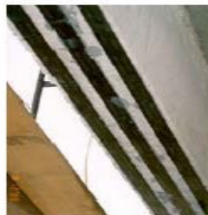
Εικόνα 8.6.: Ενίσχυση δοκού σε κάμψη [42].
