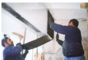
Εικόνα 8.7.: Ενίσχυση δοκού σε διάτμηση [42].
