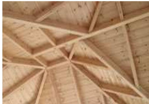
Στέγη με ακρυλικό βερνίκι
