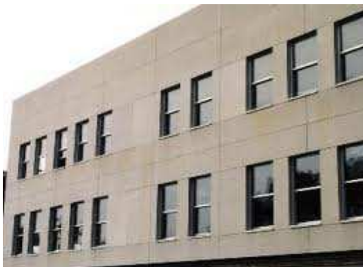
Τοιχοποιία με τσιμεντοσανίδες
