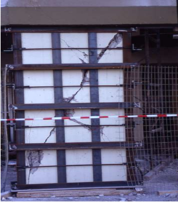
Εικόνα 2.9 Ενίσχυση τοιχώματος με χαλύβδινες λάμες
