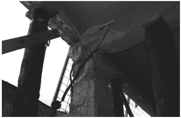
Εικόνα 1.4: Βλάβες σε μεσαίους κόμβους
