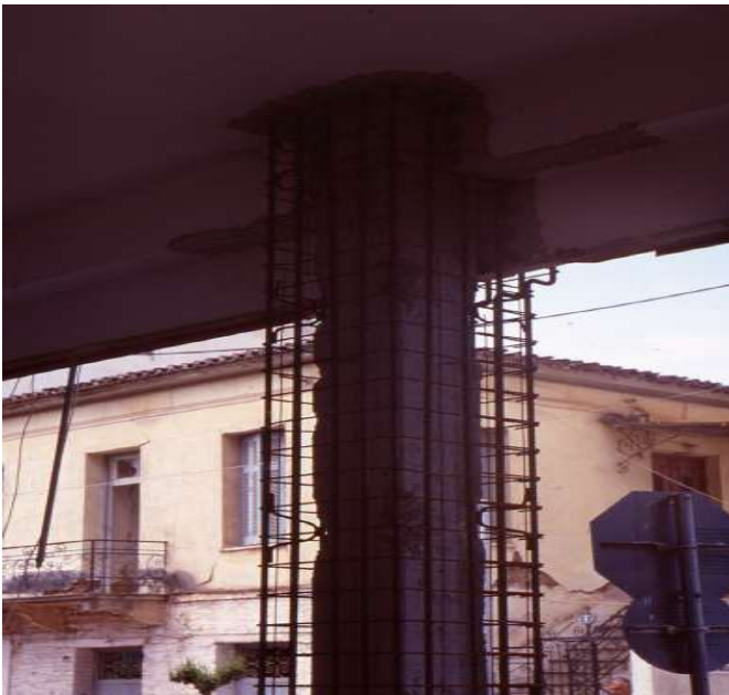
Εικόνα 2.4: Ενίσχυση με μανδύα από ινοπλισμένο σκυροδέμα
