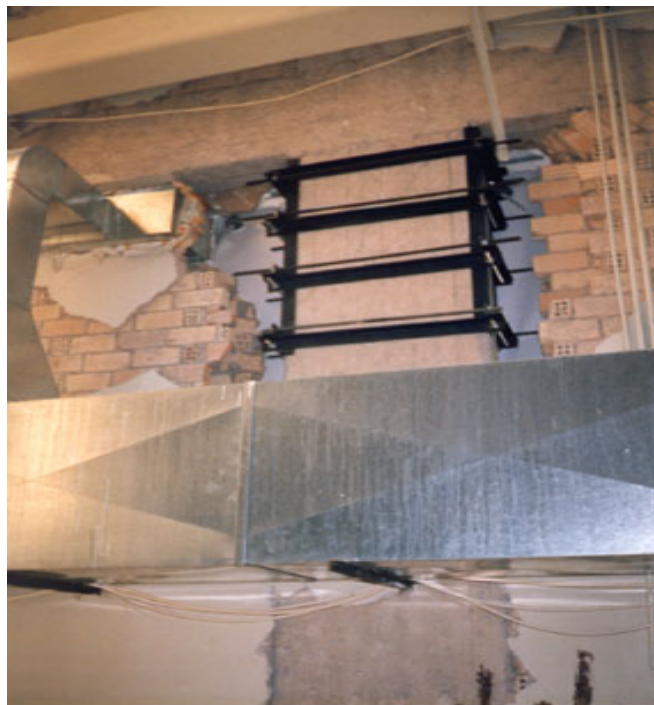
Εικόνα 2.3: Ενίσχυση κρίσιμης ζώνης υποστυλώματος με μεταλλικές λάμες
