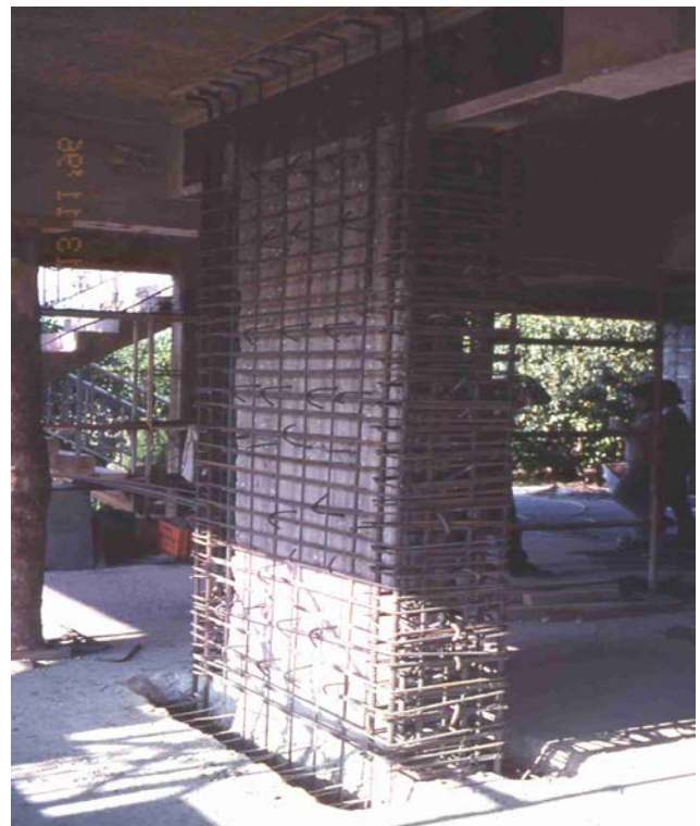
Εικόνα 2.8: Ενίσχυση με μανδύα οπλισμένου σκυροδέματος
