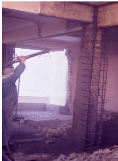
Εικόνα 2.6: Ενίσχυση με μανδύα εκτοξευόμενου σκυροδέματος
