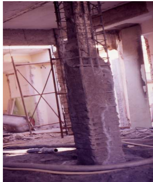
Εικόνα 2.5: Ενίσχυση με μανδύα από ινοπλισμένο σκυροδέμα
