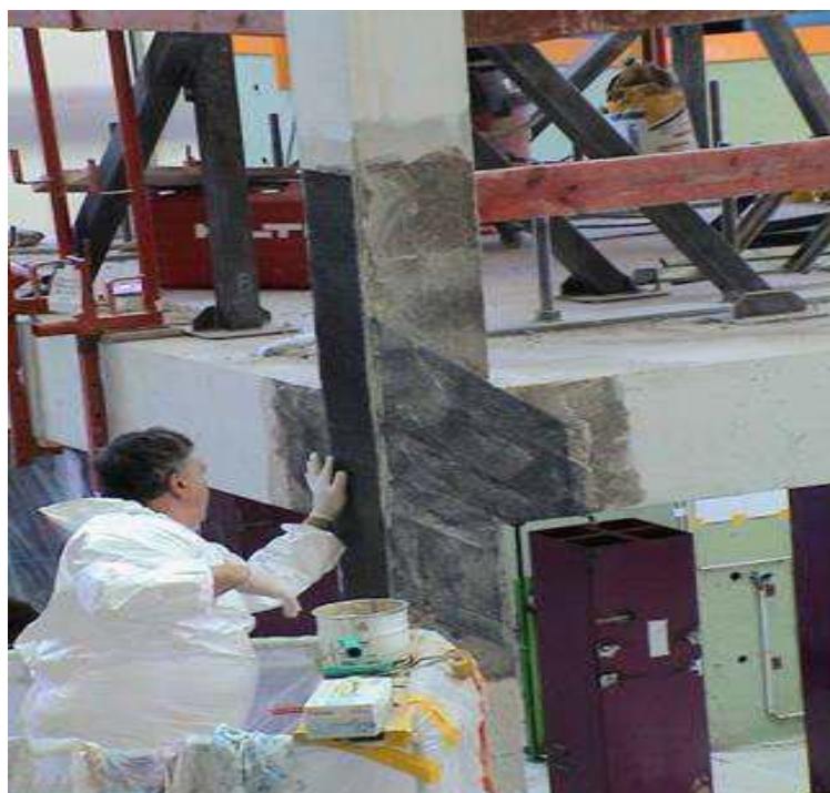
Εικόνα 2.15: Ενίσχυση κόμβου με ινοπλισμένα πολυμερή
