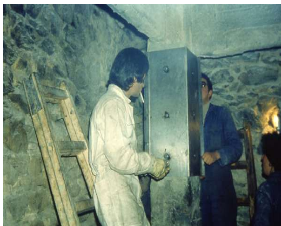
Εικόνα 2.1: Ενίσχυση υποστυλώματος με χαλύβδινα ελάσματα
