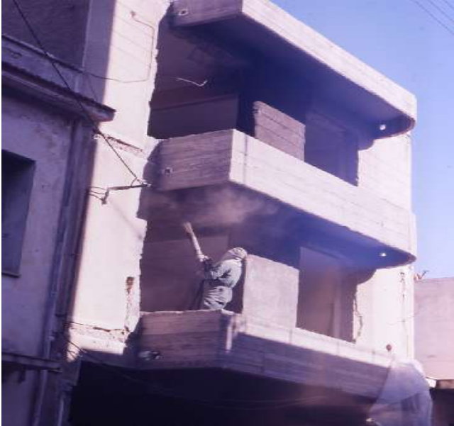
Εικόνα 2.11: Χρήση εκτοξευόμενου σκυροδέματος
