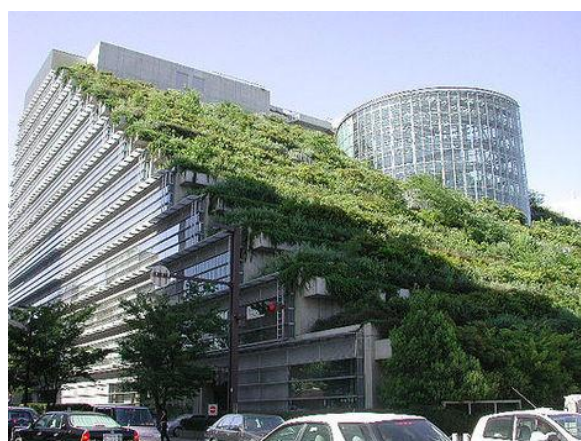
Εικόνα : Πράσινη ταράτσα σε κτίριο.
