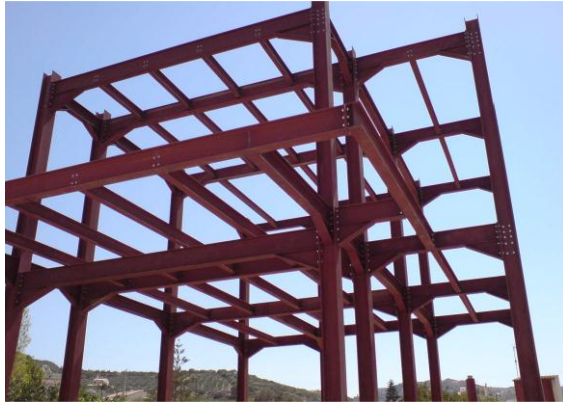
Εικόνα : Μεταλλικός σκελετός κτιρίου.
