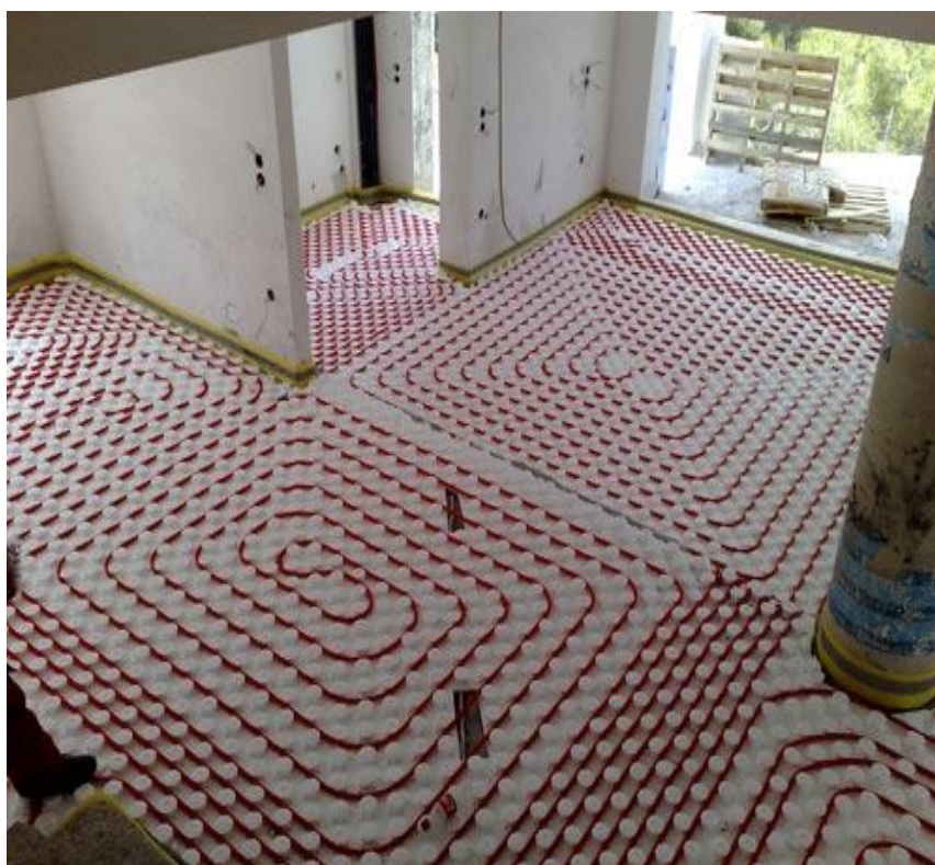
Εικόνα : Η ενδοδαπέδια θέρμανση πριν την τοποθέτηση του δαπέδου.
