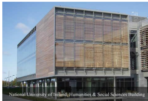
Εικόνα : Σκίαση κτιρίου με εξωτερικά σκίαστρα.
