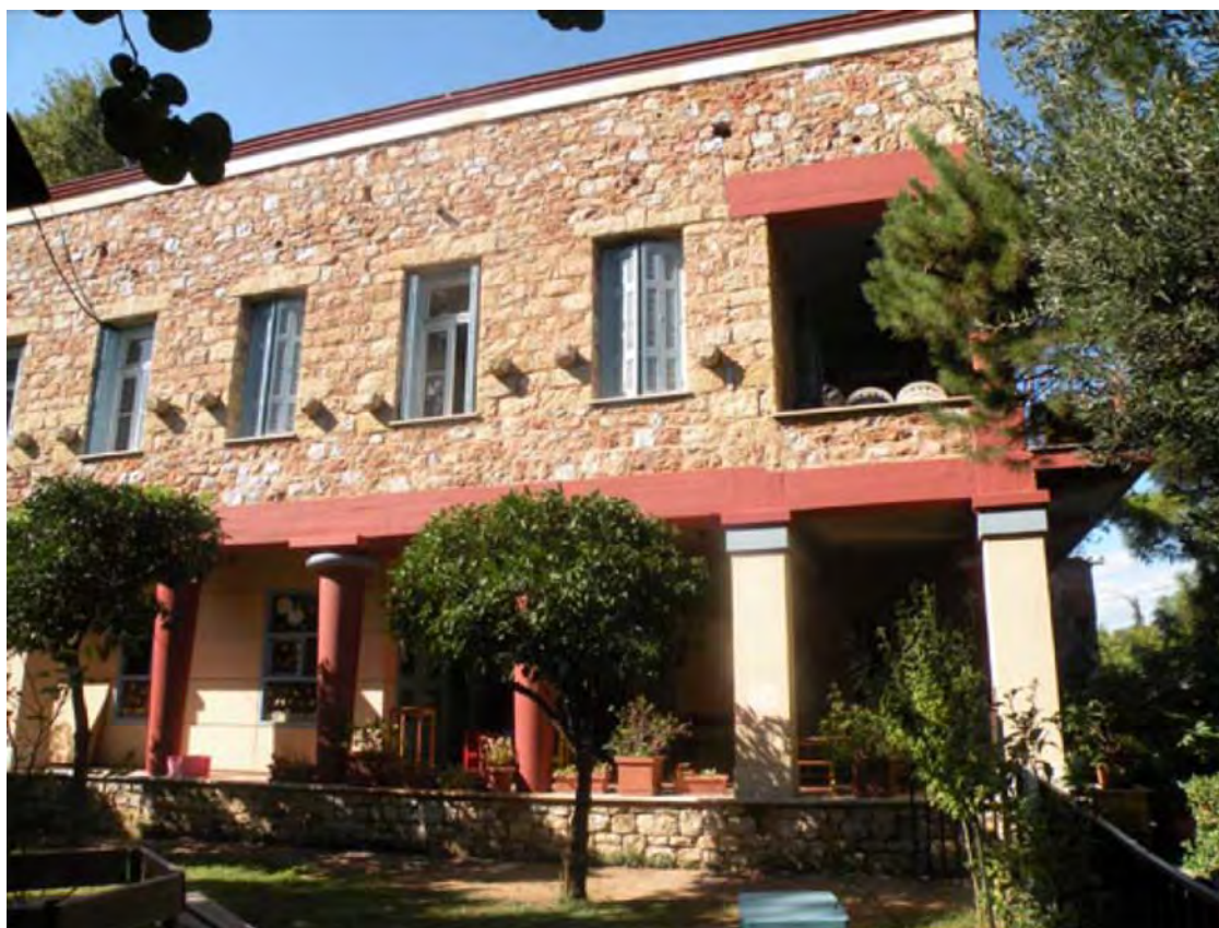
Εικ.175 Η νότια όψη της ιδιωτικής κατοικίας Ζουμπουλίδη
