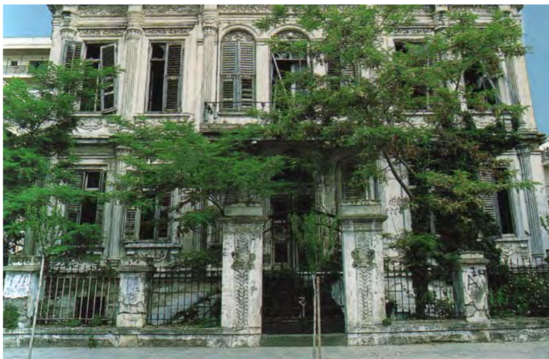
Εικ.44 Κτίριο εκλεκτικιστικής αρχιτεκτονικής
