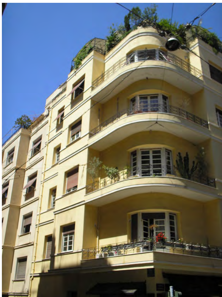
Εικ.172 Κτίριο στην οδό Σκουφά
