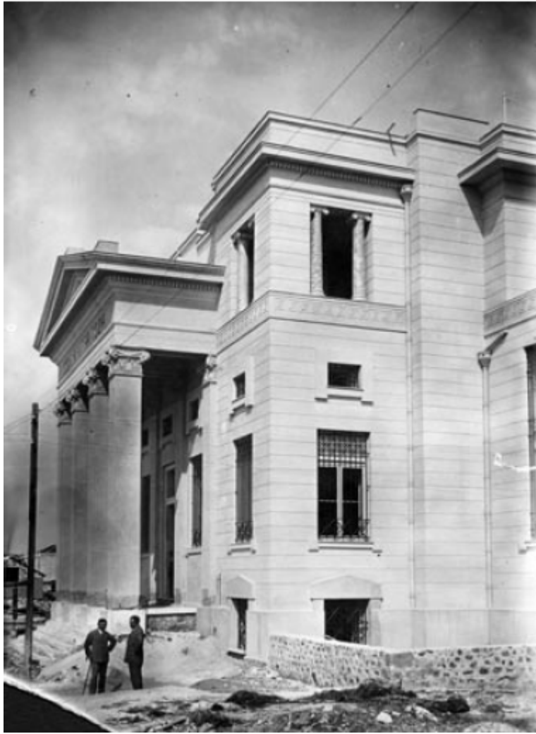
Εικ.80 Υποκατάστημα Σερρών
