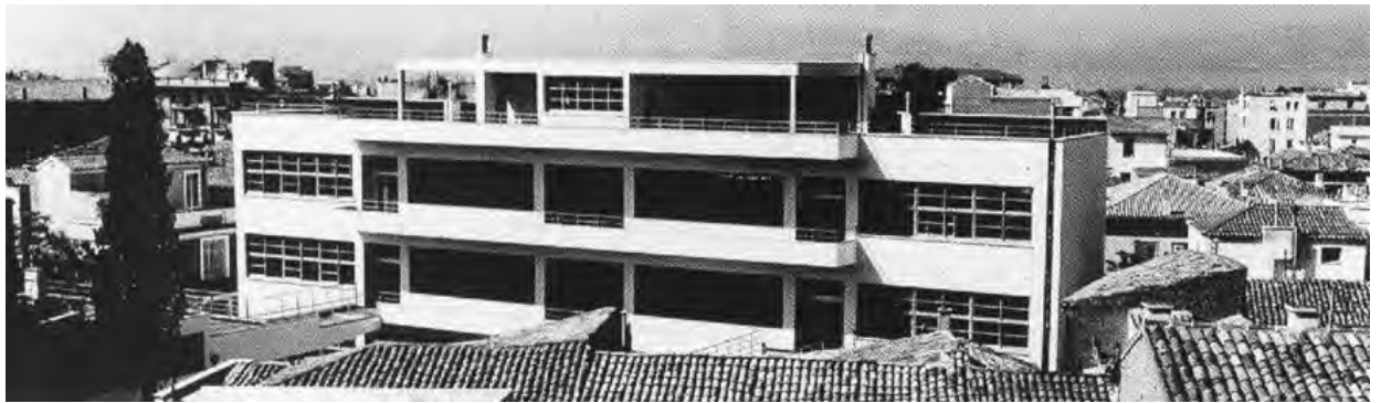
Εικ.60 Δημοτικό σχολείο Οδού Κωλέττη (1932) – Ν. Μητσάκης
