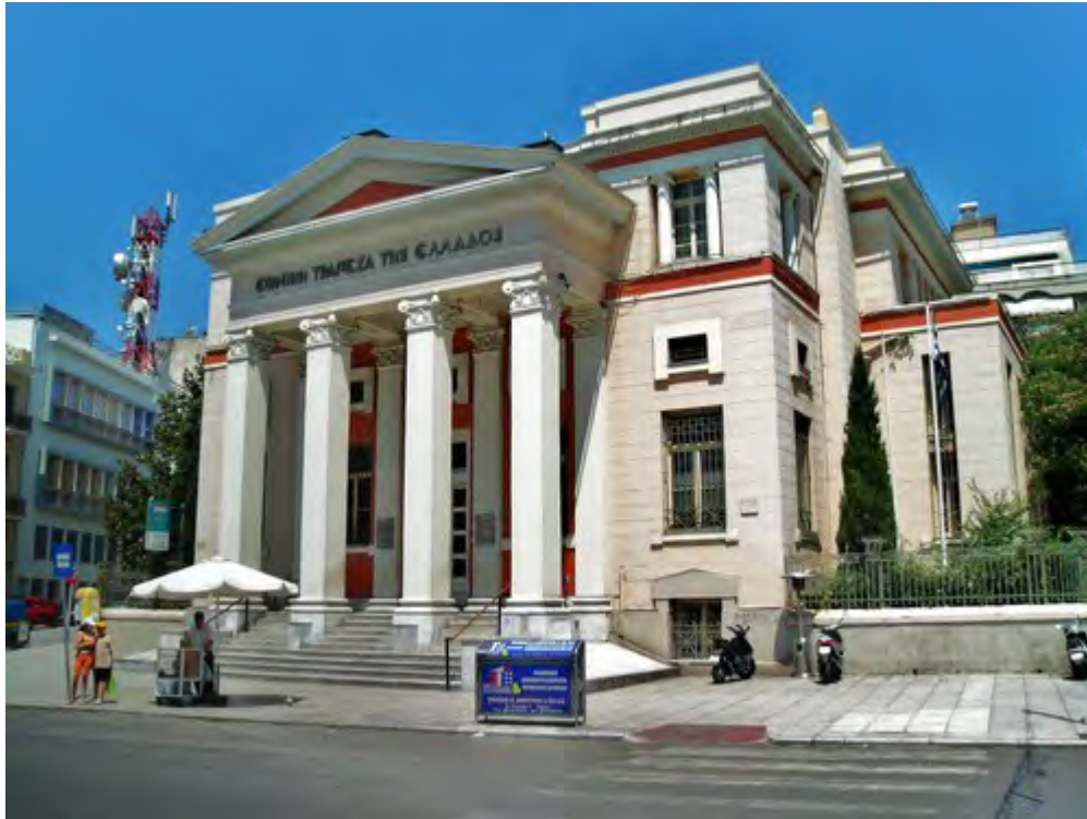
Εικ.81 Υποκατάστημα Σερρών στην σημερινή του κατάσταση
