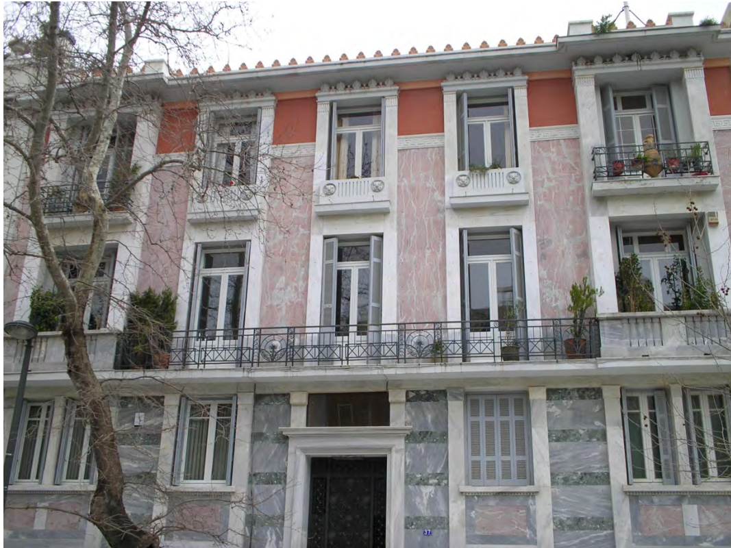
Εικ.109 Κτίριο στην οδό Διονυσίου Αρεοπαγίτου 37
