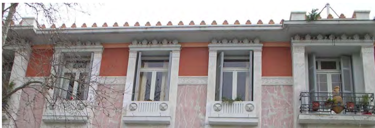
Εικ.114 λεπτομέρεια στέγης κτιρίου στην οδό Διονυσίου Αρεοπαγίτου 37
