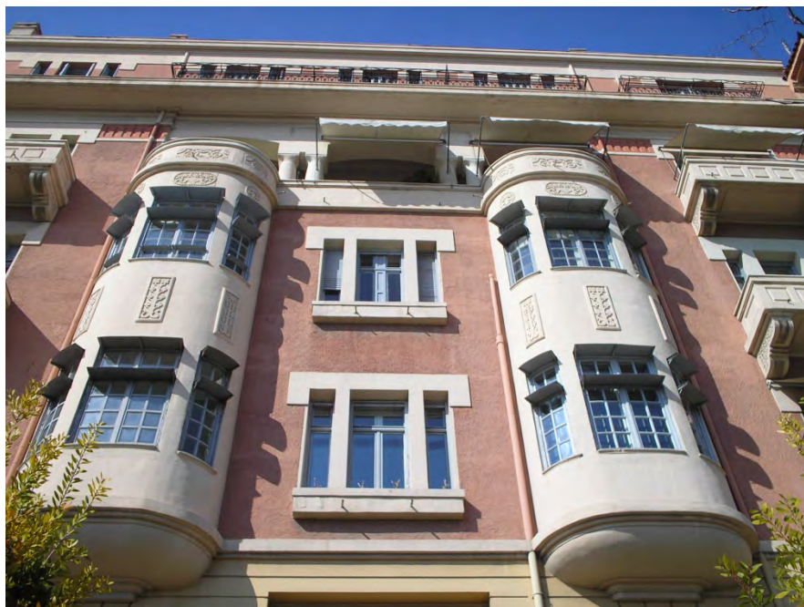
Εικ.154 Κτίριο στην Βασ. Σοφίας 55 (1927)
