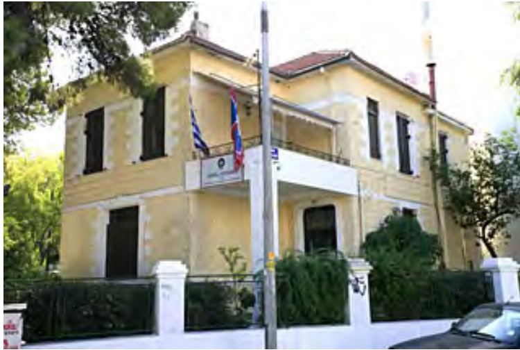
Εικ.85 Διώροφη κατοικία του Μεσοπολέμου, οδός Ηρακλείου 58 & Αγίας Λαύρας 73
