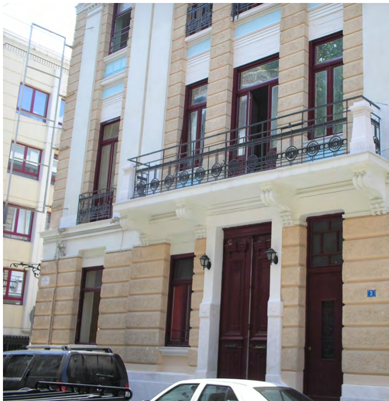
Εικ.104 Κτίριο στην Οδό Ρεθύμνου 3 – Κυβέλης
