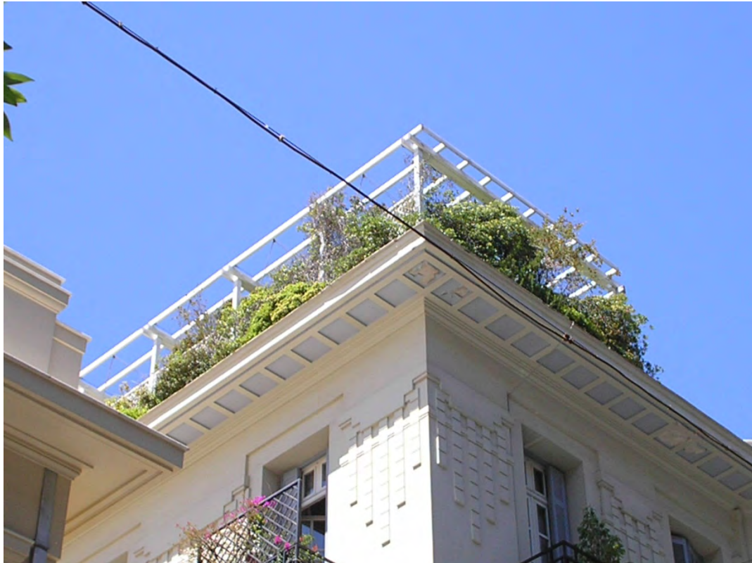
Εικ.101 Χαρακτηριστική πέργκολα – Κτίριο στην οδό Σκουφά 59-61 και Μαντζάρου
