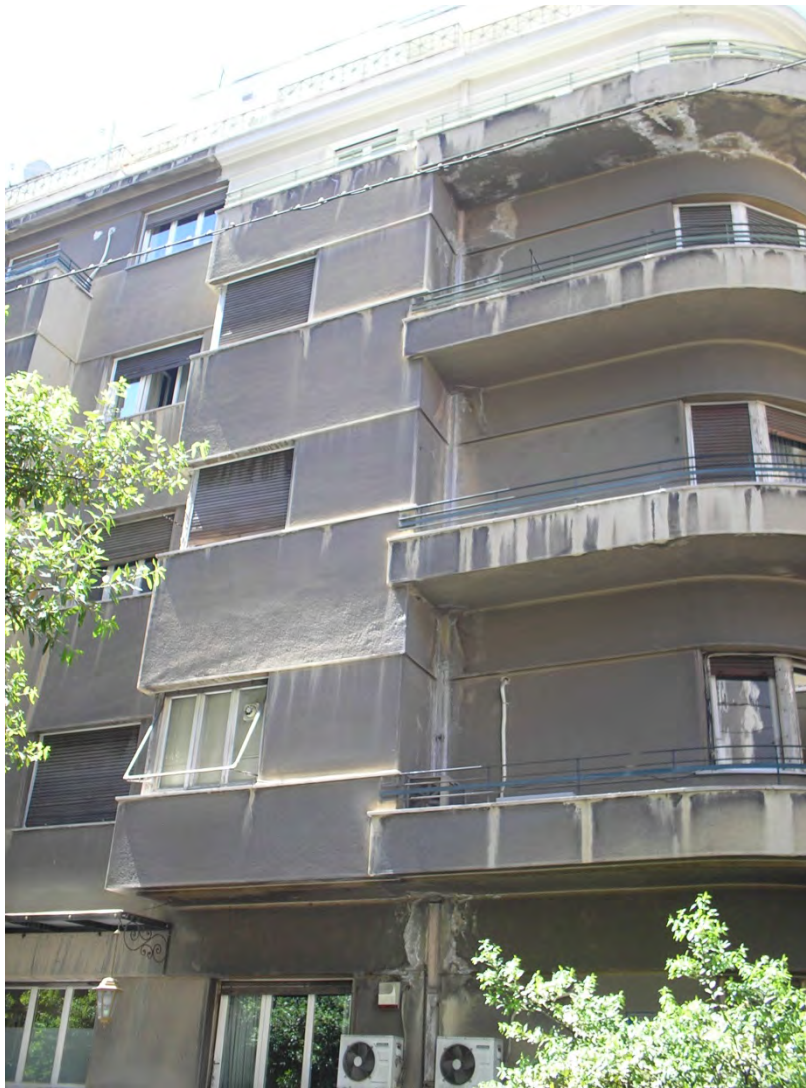
Εικ.116 πολυκατοικία στην οδό Σκουφά 65 και Σινά 38
