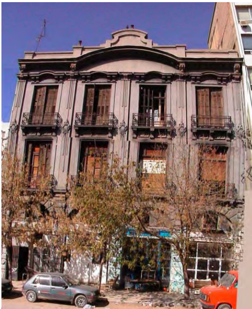
Εικ.43 Κτίριο εκλεκτικιστικής αρχιτεκτονικής
