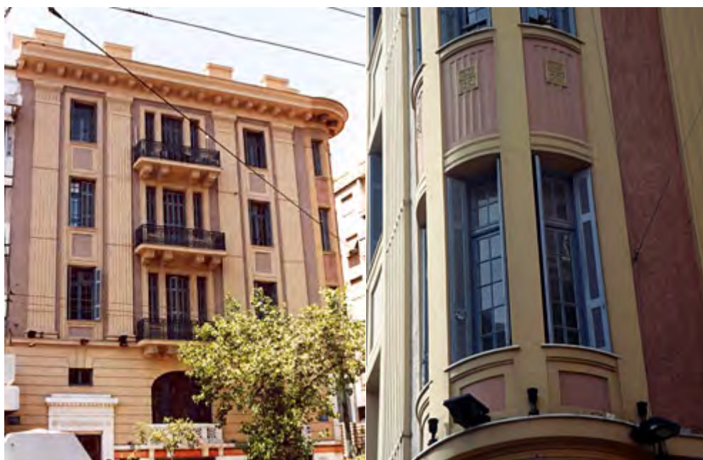
Εικ.153 Εκλεκτικιστικό τετραώροφο κτίριο - Πατησίων 75 & Γκυλφόρδου (1924)
