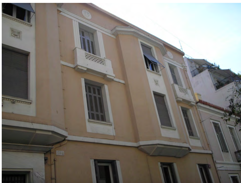
Εικ.115 Κτίριο στο Κέντρο της Αθήνας
