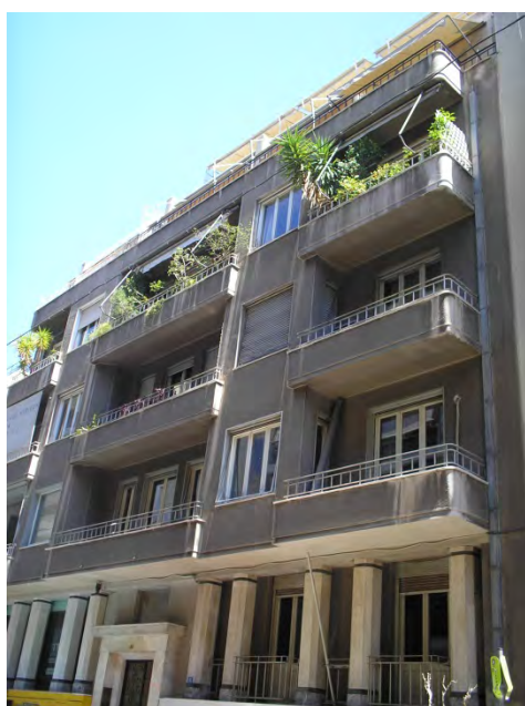
Εικ.40 Κτίριο στην Οδό Σκουφά 10
