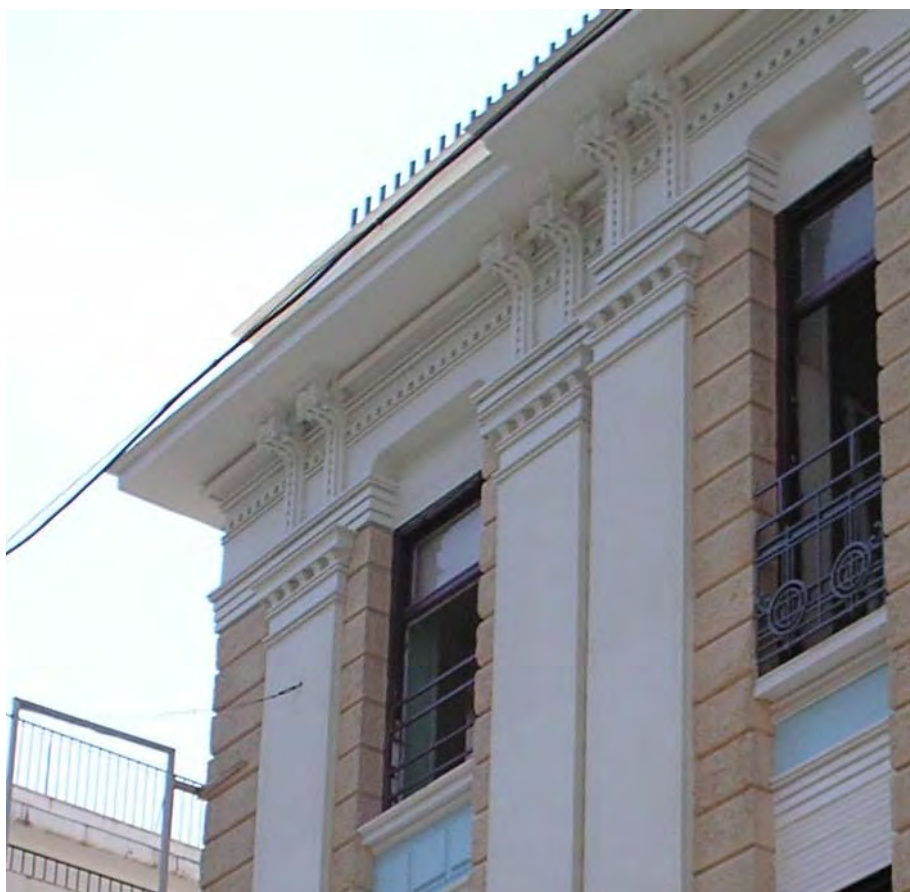
Εικ.112 λεπτομέρεια στέψης κτιρίου στην οδό Ρεθύμνου 3 - Κυβέλης
