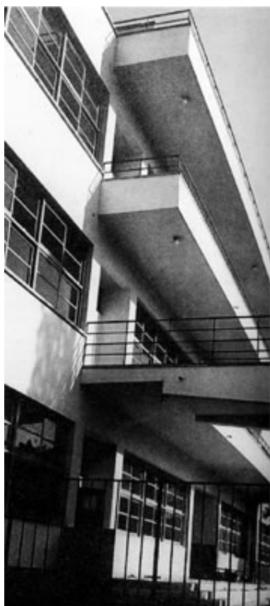
Εικ.61 Δημοτικό σχολείο Οδού Κωλέττη (1932) – Ν. Μητσάκης
