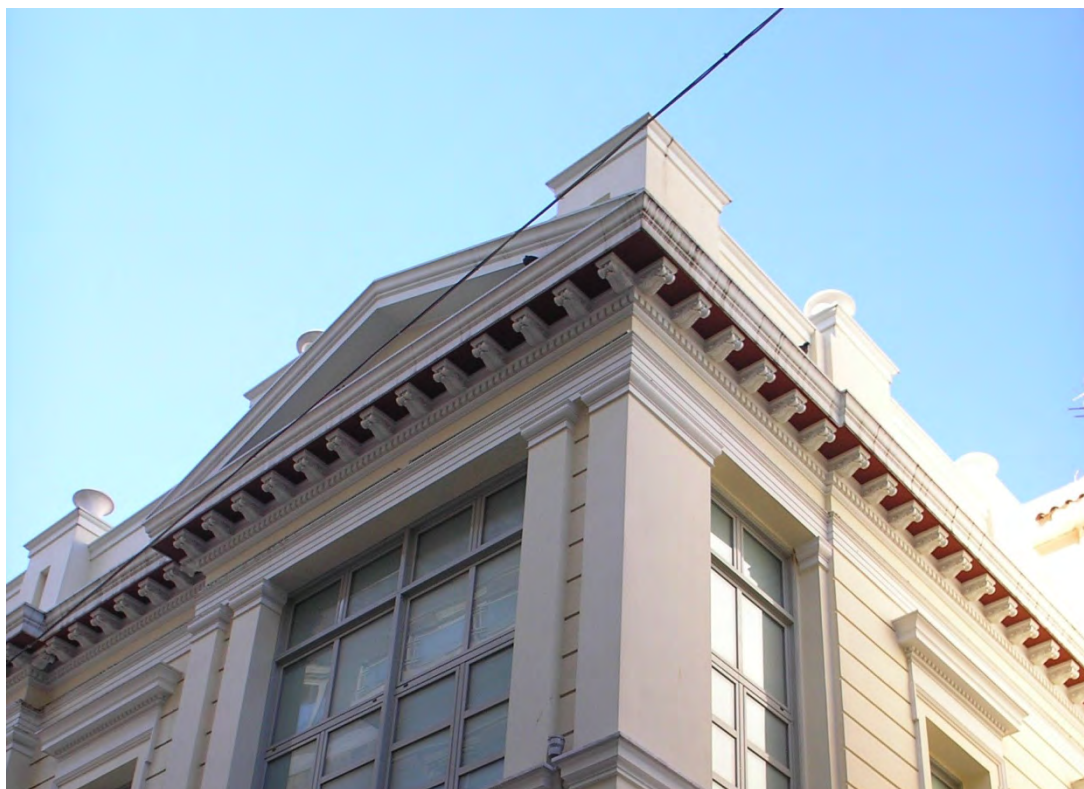
Εικ.113 λεπτομέρεια στέψης κτιρίου στο Κέντρο της Αθήνας
