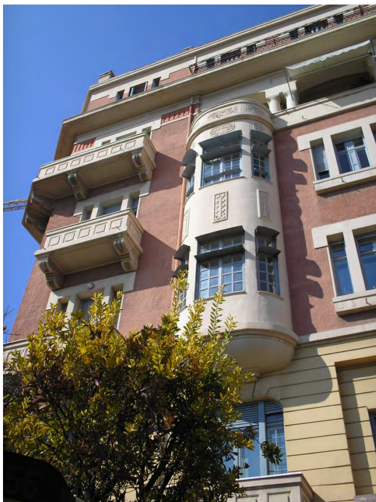
Εικ.106 Κτίριο στην Βασ.Σοφίας 55
