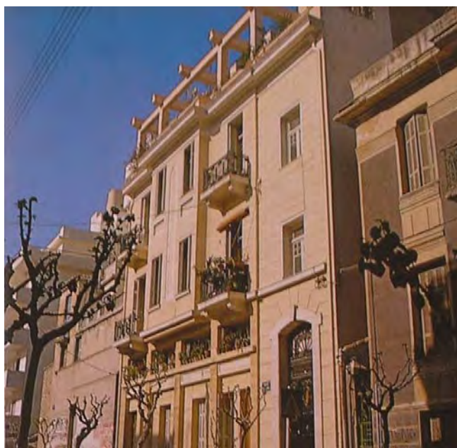
Εικ.100 Κτίριο στην οδό Αμερικής 21 (1931) - Κ. Κιτσίκης,
