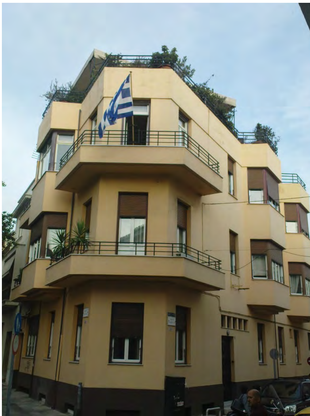
Εικ. 48 Κτίριο στην Πλάκα
