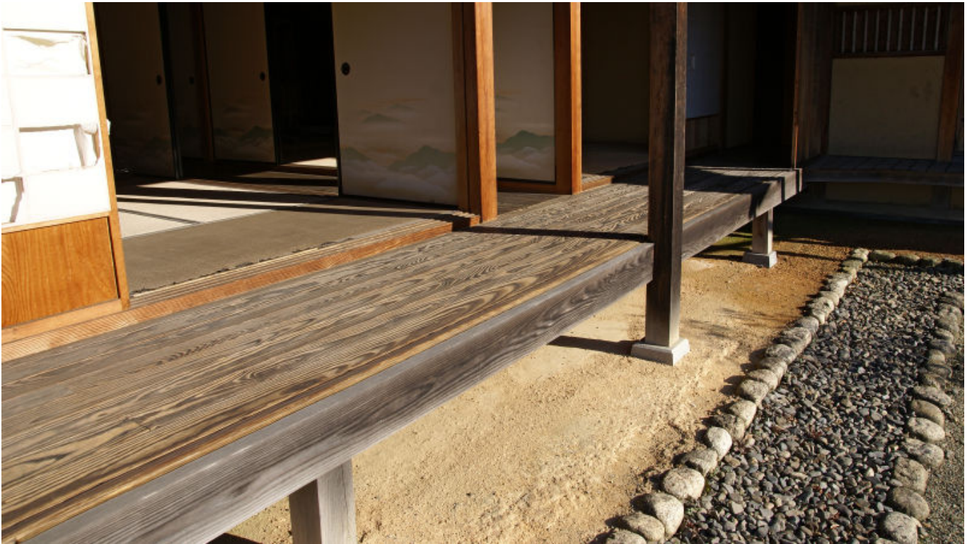
Εικόνα 74 – Kure-en , Οι σανίδες είναι παράλληλες με τον τοίχο
