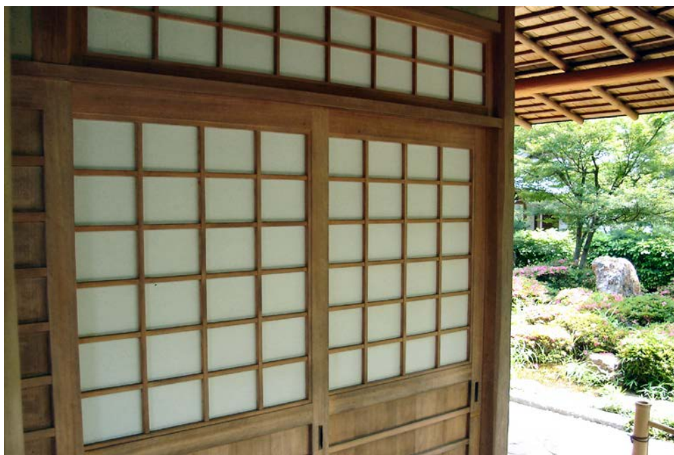
Εικόνα 35 – Αδιαφανής εξωτερικός τοίχος Shoji
