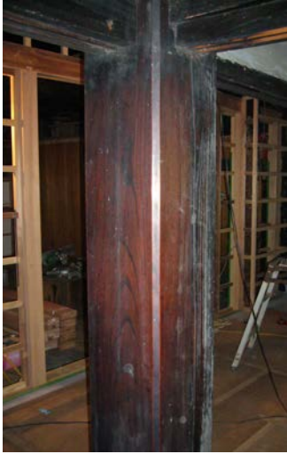
Εικόνα 80 – Το Daikokubashira είναι το κεντρικό υποστύλωμα και κατασκευάζεται συνήθως από ξύλο Zelkova ή Βελανιδιάς
