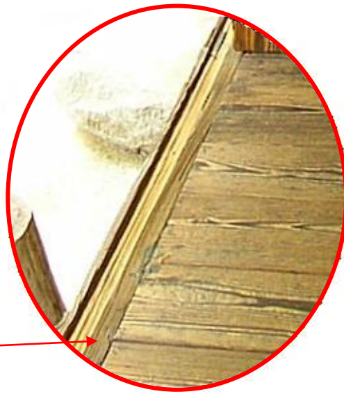
Εικόνα 73 – Λεπτομέρεια από το τελείωμα της βεράντας όπου φαίνεται η σανίδα κατά της φθοράς
