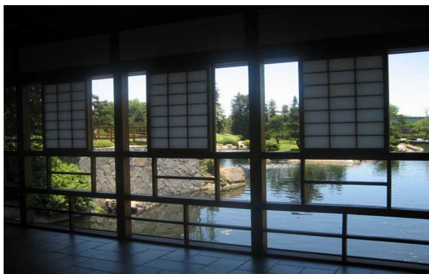
Εικόνα 53 – Shoinmado : τα κλασσικά συρόμενα ιαπωνικά παράθυρα από shoji και από γυαλί
