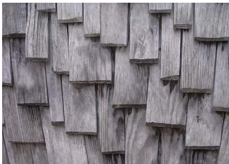
Εικόνα 15 – Ξυλοκέραμα στέγης
