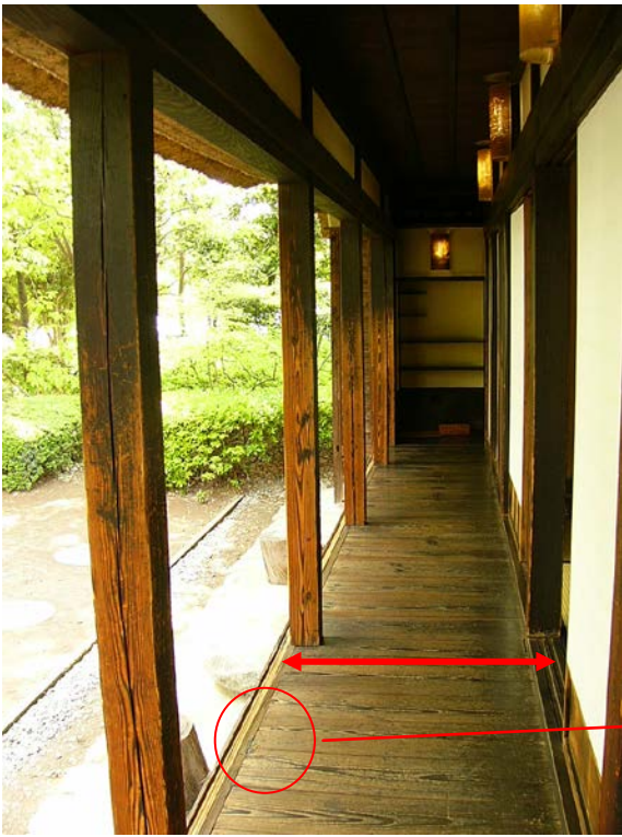
Εικόνα 72 – Kirime-en Οι σανίδες είναι κάθετες στον τοίχο
