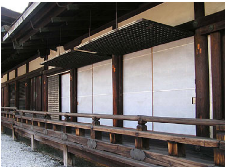
Εικόνα 54 – Shitomido εφαρμογή σε τοίχο-πόρτα από fusuma
