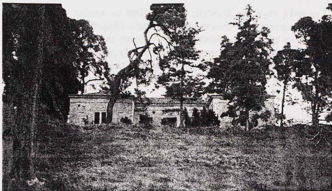
Η δυτική πλευρά από το κονάκι του Ε. Τομπάζη από τον επαρχιακό δρόμο.
